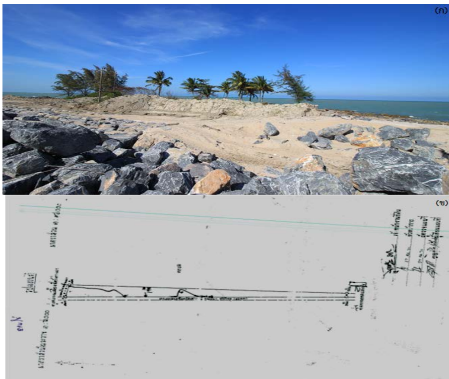
รูปที่ 12 แนวเสาไฟฟ้าเดิม และแผนที่/โฉนดที่ดินของพื้นที่หาด
