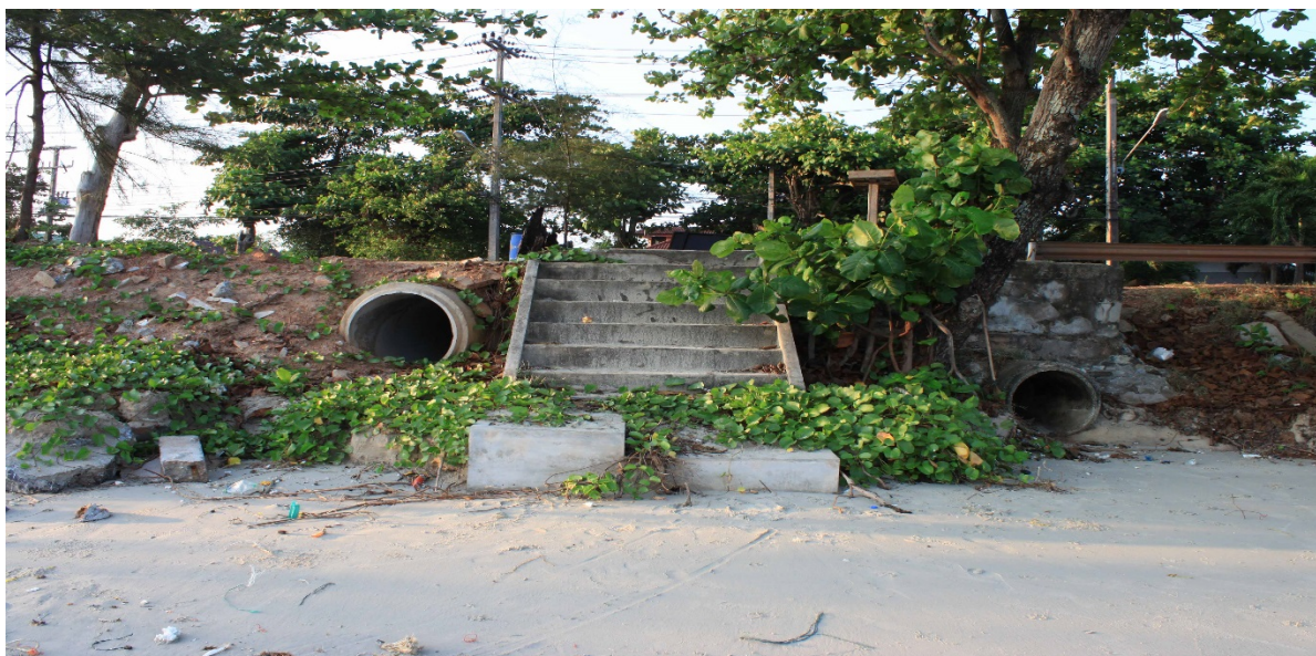
รูปที่ 2 การเสริมสันทรายด้วยคอนกรีต ระบบระบายน้ำ และการปลูกพืชในบริเวณสันทราย (Vegetation) ณ หาดแหลมแม่พิมพ์
