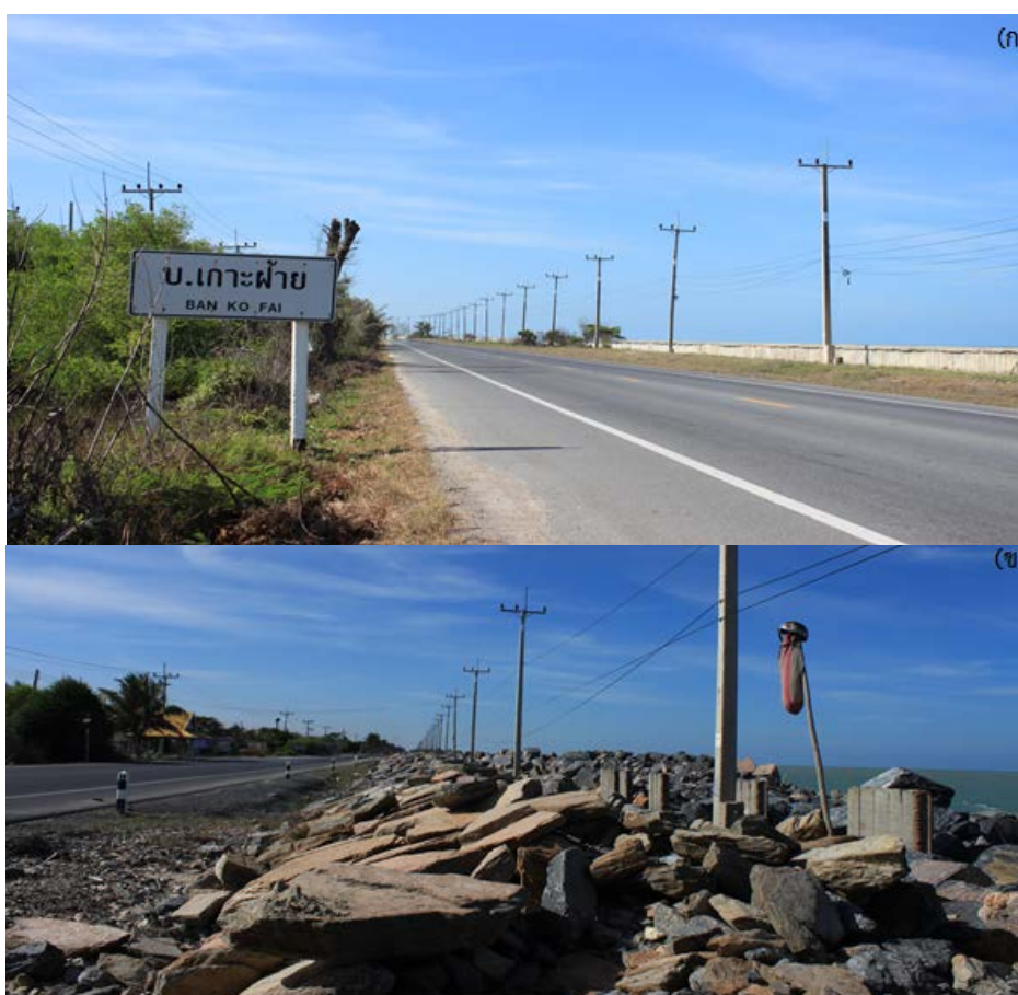
รูปที่ 10 กำแพงป้องกันคลื่นริมชายหาด (Sea wall) และเขื่อนหินทิ้ง (Revetment) ณ หาดบ้านเกาะฝ้าย
