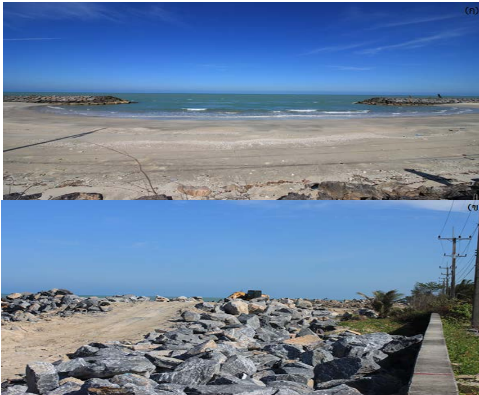
รูปที่ 11 รอดักทรายรูปตัวที (T-Groin/T-Groyne) และการเสริมทรายชายหาด (Beach Nourishment) ณ หาดบ้านเกาะฝ้าย
