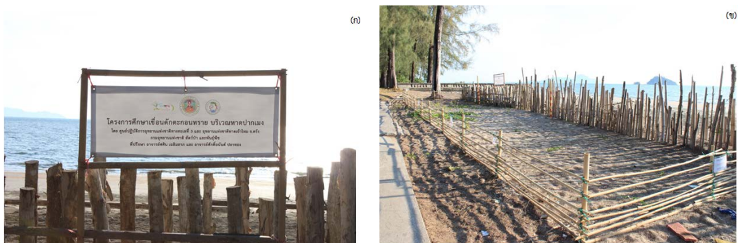
รูปที่ 23 โครงการทดลองเชืงนดักตะกอนทราย ณ หาดปากเมง
