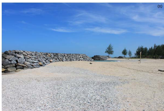
รูปที่ 18 รอดักทรายรูปตัวที (T-Groin/T-Groyne) และการเสริมทรายชายหาด (Beach Nourishment)
