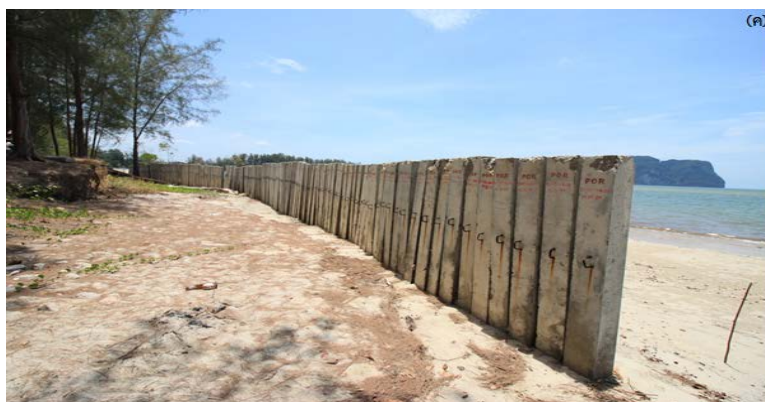
รูปที่ 29 กำแพงป้องกันคลื่นริมชายหาด (Sea wall) และเสาคอนกรีตป้องกันคลื่น ณ หาดคลองสน
