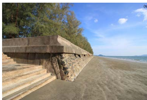
รูปที่ 22 กำแพงป้องกันคลื่นริมชายหาด (Sea wall) และระบบระบายน้ำ ณ หาดปากเมง
