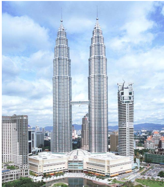
ภาพ 2-4 (ซ้าย) ผังอาคารปิโตรนัส ซึ่งมีที่มาจากรูปทรงเรขาคณิตแบบอิสลาม (ขวา) อาคารแฝดปิโตรนัส กรุงกัวลาลัมเปอร์ ประเทศมาเลเซีย (ที่มา: (ซ้าย) wikipedia; (ขวา) http://www.tourmalaysia.com/2010/12/17/kuala-lumpur-petronas-twin-towers/ )
