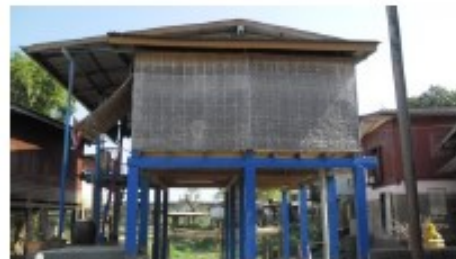
ภาพที่ 49 การใช้ไม้ไผ่สานเป็นผนังของบ้าน
