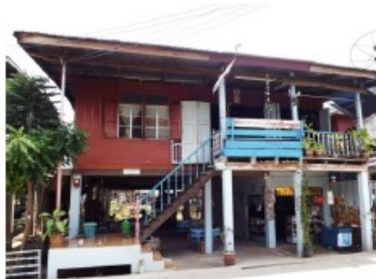
ภาพที่ 37 ระเบียงไม้ชานบ้านเชื่อมจากบันไดไต่ปูนบ้าน ซึ่งเป็นรูปแบบที่พบเห็นได้ทั่วไปในบ้านปากคลอง
