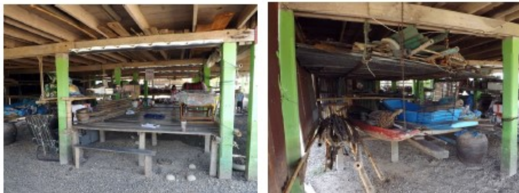
ภาพที่ 4: การสร้างห้องหรือชั้นเก็บของชั่วคราวยกระดับ โดยสามารถปรับระดับเลื่อนขึ้นลงให้สัมพันธ์กับระดับน้ำท่วมได้สะดวก นับว่าเป็นองค์ประกอบที่น่าสนใจ สำหรับการปรับตัวอยู่ร่วมกับน้ำ และลดความเสียหายจากปัญหาน้ำท่วมได้อย่างมาก
