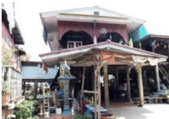
ภาพที่ 29 บ้านยกใต้ถุนสูงเพื่อเลี่ยงผลกระทบจากน้ำท่วม และติดเสาสูงขึ้นเพื่อให้พ้นระดับน้ำท่วม
