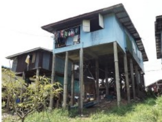
ภาพที่ 16 การตักเสาสูงขึ้นตามระดับน้ำท่วมที่ได้รับผลกระทบในแต่ละพื้นที่
