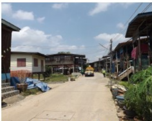
ภาพที่ 68 สภาพถนนขนานแม่น้ำภายในชุมชน
