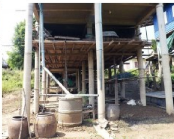
ภาพที่ 31 การใช้โครงเคร่าไม้ไผ่ยึดเป็นชั้นลอยไว้หลายระดับไว้เพื่อเก็บของและยึดระหว่างช่วงเสาเป็นการเสริมการรับแรงโก่งคาะตามภูมิปัญญาชาวบ้าน
