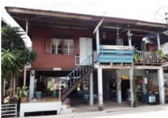
ภาพที่ 28 บ้านยกใต้ถุนสูงเพื่อเลี่ยงผลกระทบจากน้ำท่วม และติดเสาสูงขึ้นเพื่อให้พ้นระดับน้ำท่วม
