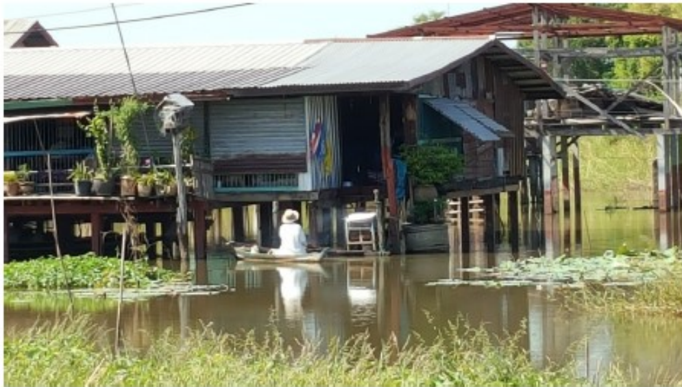
ภาพที่ 3: บ้านยกได้สูงเป็นรูปแบบสถาปัตยกรรมพื้นถิ่นที่สะท้อนเอกลักษณ์การปรับตัวอยู่ร่วมกับน้ำ ที่พบเห็นเป็นส่วนใหญ่ในชุมชนที่ตั้งถิ่นฐานริมแหล่งน้ำ จากภาพด้านขวาจะสังเกตเห็นว่าบ้านที่สร้างใหม่จะยกได้สูงเพิ่มสูงขึ้นอย่างเห็นได้ชัด
