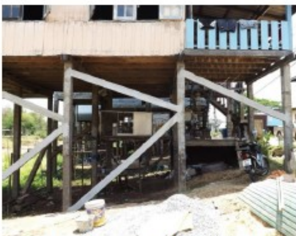
ภาพที่ 30 การค้ำยันโครงสร้างเสาหลังจากติดบ้านการค้ำยันเสา
