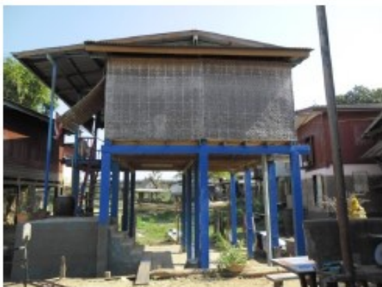
ภาพที่ 34 ผนังโปร่งระบายอากาศ ทำจากไม้ไผ่จักสาน และสามารถเปิดเป็นบานกระทุ้ง
