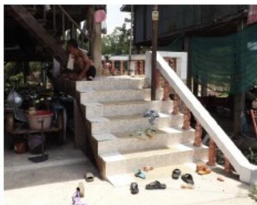
ภาพที่ 17 การต่อเติมบันไดคอนกรีตจะพบในหลายครัวเรือน โดยทำขึ้นหลังจากการติดบ้าน
