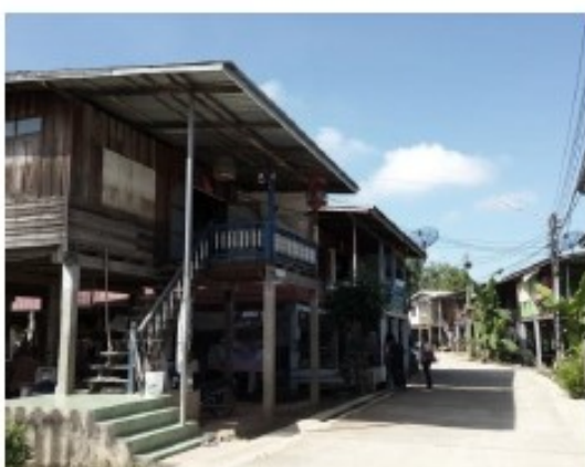
ภาพที่ 38 การรวมกลุ่มเรือนในพื้นที่บ้านปากคลอง กลุ่มเรือนตามแนวถนนขนานแม่น้ำ
