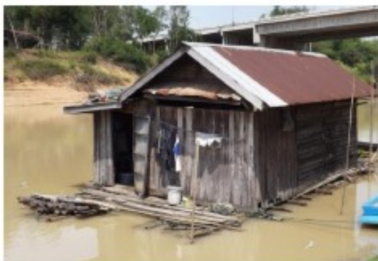
ภาพที่ 14 การปรับสภาพบ้านเรือนเพื่ออยู่ร่วมกับน้ำ และลดความเสียหายจากปัญหาน้ำท่วมในรูปแบบเรือนแพหรือบ้านลอยน้ำ
