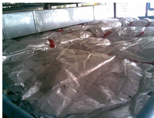
รูปที่ 3.9 ระบบท่อน้ำเย็นและการติดตั้งฉนวนกันความร้อนด้านบนแผงน้ำเย็น
