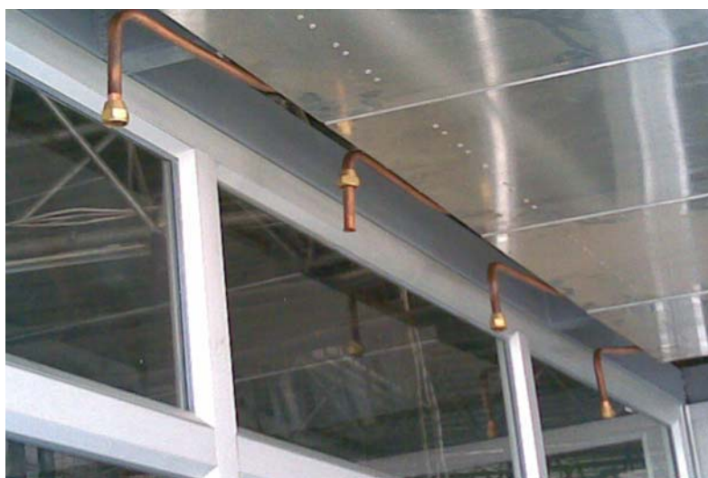
รูปที่ 3.7 การจัดแบ่งท่อทองแดงออกเป็น 6 ส่วน
