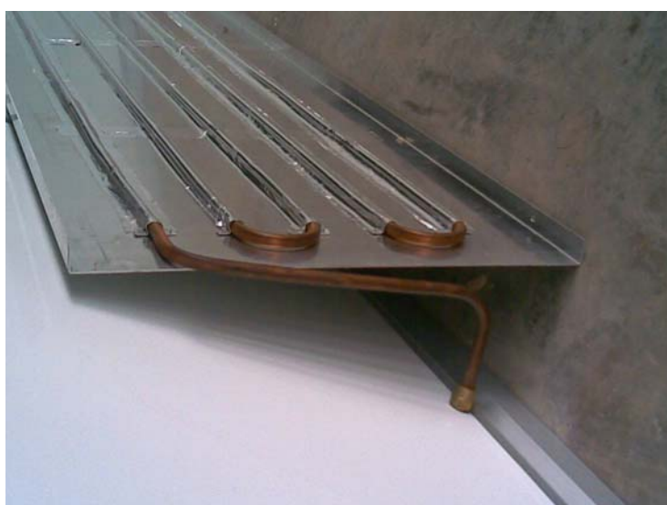
รูปที่ 3.4 การพับขอบแผงอะลูมิเนียมสำหรับยึดประกอบ
