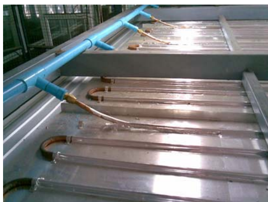
รูปที่ 3.9 ระบบท่อน้ำเย็นและการติดตั้งฉนวนกันความร้อนด้านบนแผงน้ำเย็น
