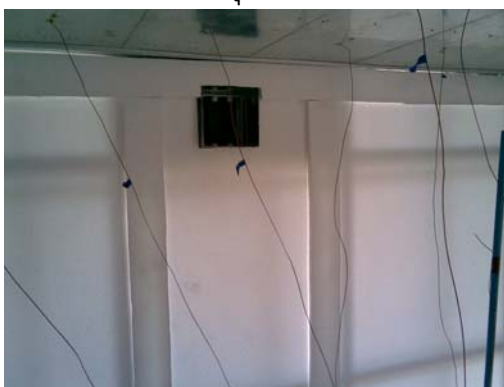
รูปที่ 3.12 การติดตั้งฉนวนกันความร้อนรอบห้องด้วยโฟม
