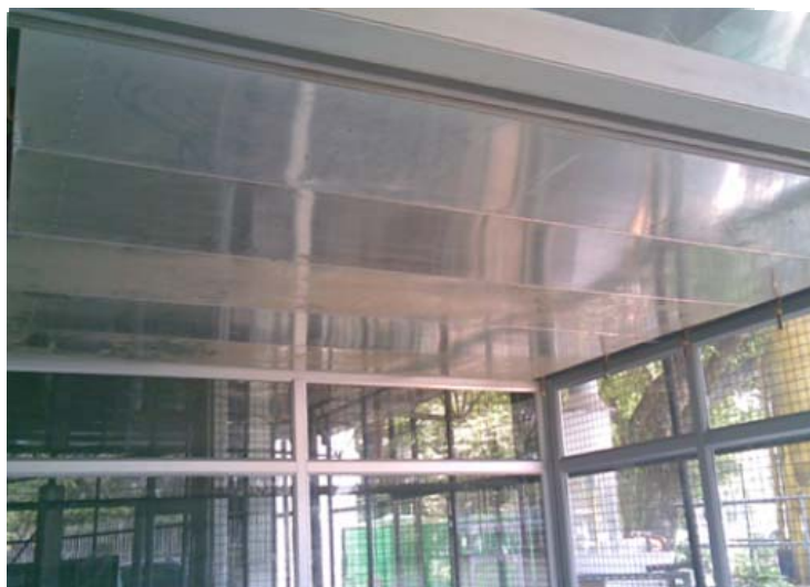
รูปที่ 3.3 แผงน้ำเย็นซึ่งประกอบด้วยแผ่นอะลูมิเนียม 6 แผ่น
