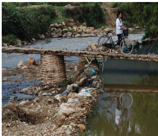
รูป 7-68 ฐานสะพานที่ทำจากการจักสาน พื้นสะพานก็เป็นไม้ไผ่เช่นกัน จ.เดียนเบียนฟู ประเทศเวียดนาม
