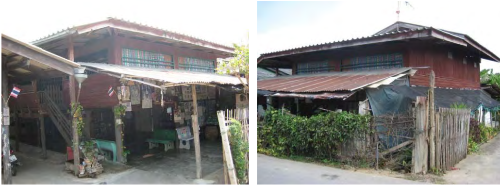
รูป 5-30 การต่อเติมหลังคาบริเวณหน้าบ้านเพื่อทำการค้าในหมู่ 1
