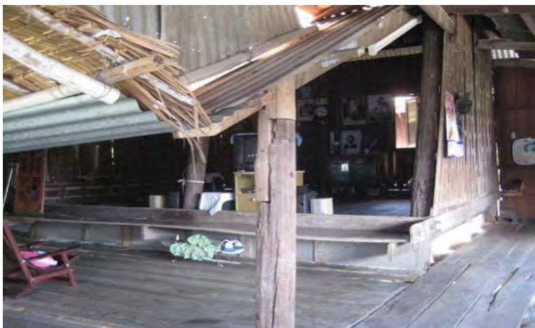
รูป 5-23 ไม้แป้นท่อน และการถ่ายระดับของเรือนนอนและระเบียง
