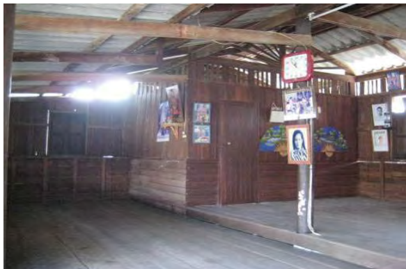
รูป 5-26 การลดระดับพื้นภายในของเรือนนอนและโถง
