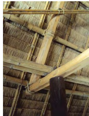
รูป 7-37 (ขวา) ฝักมะขาม หรือ ปิง รูป 7-40 (ขวา) ชื้อ รูป 7-43 (ขวา) แปหัวเสา
