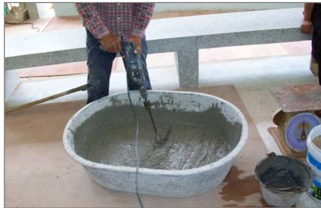
รูปที่ 4.9 การผสมปูนฉาบสำเร็จรูปในท้องตลาดที่ภาคสนามโครงการก่อสร้าง
