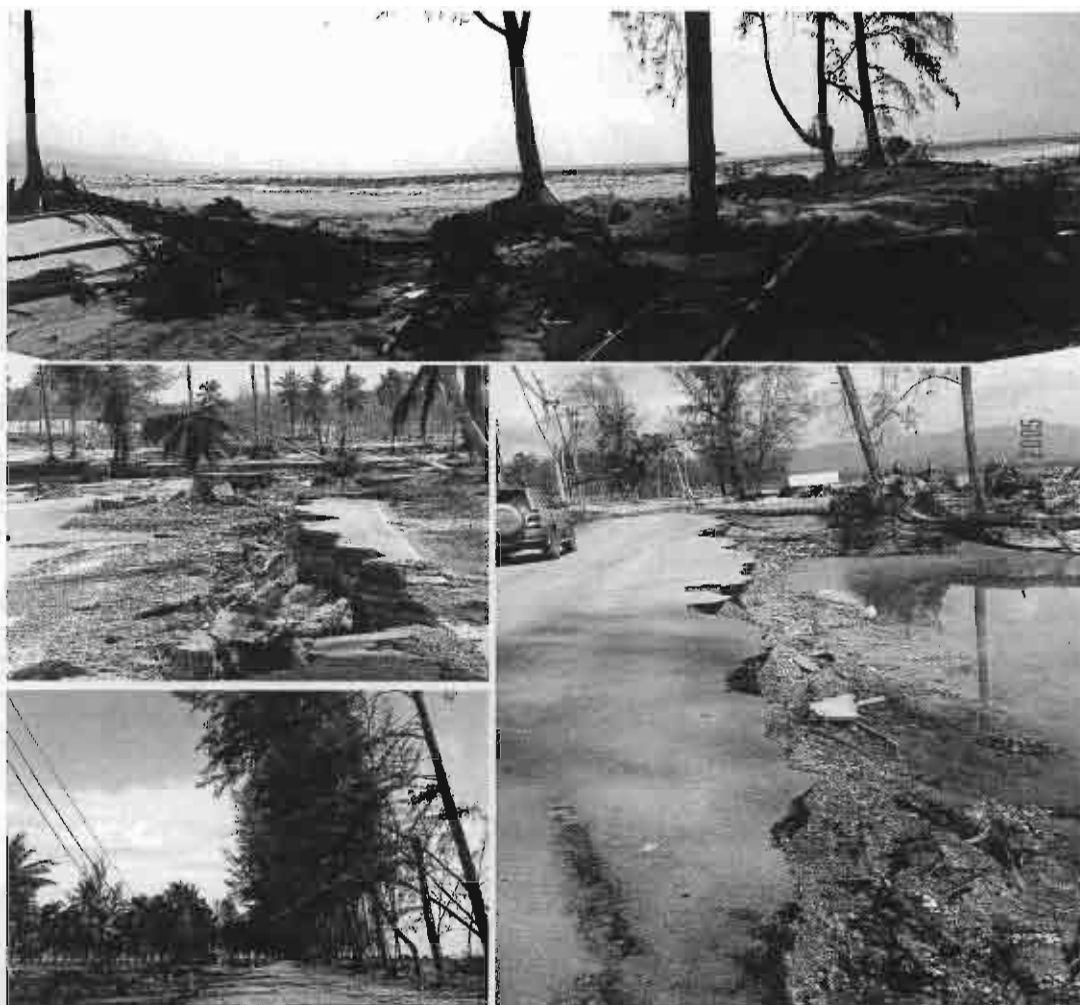
รูปที่ 4.3 ภาพบันทึกจากการสำรวจภาคสนามแสดงสภาพความเสียหายจากการกัดเซาะชายฝั่งบริเวณแหลมปะการัง (ภาพบนสุดถ่ายไปทางทิศตะวันตก เมื่อวันที่ 7 มกราคม 2548) ภาพกลางและล่างบันทึกเมื่อวันที่ 14 พฤษภาคม 2548 แสดงการกัดเซาะอย่างต่อเนื่องจากมรสุม
