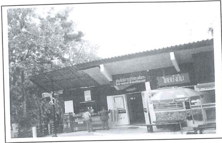
รูปที่ 3.3 อาคารที่ติดตั้งเครื่องบันทึกผลที่ศูนย์บริการนักท่องเที่ยวใกล้น้ำตกแม่กลาง
