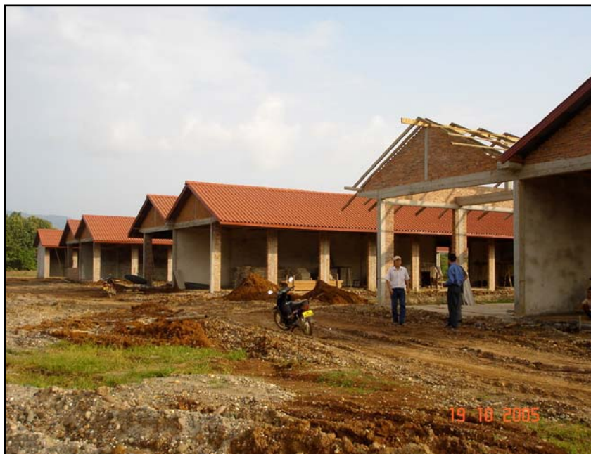
รูปที่ 6.9 ตลาดจำหน่ายสินค้าจีนที่กำลังทำการก่อสร้าง (ตลาดถาวร)
