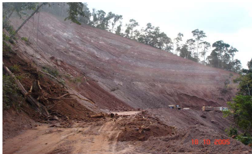
รูปที่ 7.16 สภาพการก่อสร้างเส้นทาง R3E ช่วงที่ 2
