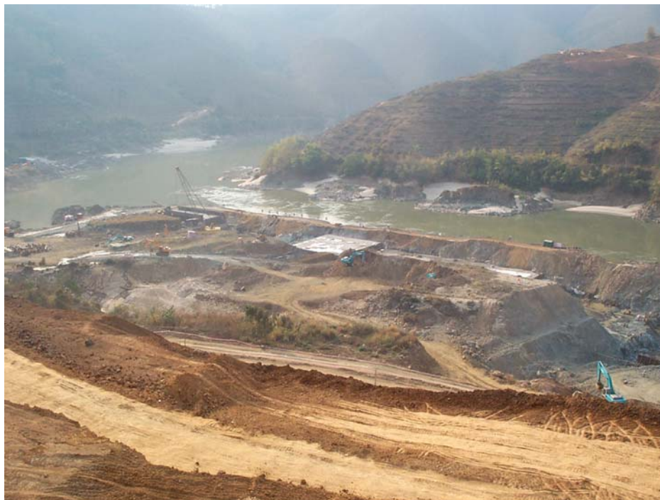
รูปที่ 7.25 เขื่อนจิ่งหังที่กำลังก่อสร้าง
