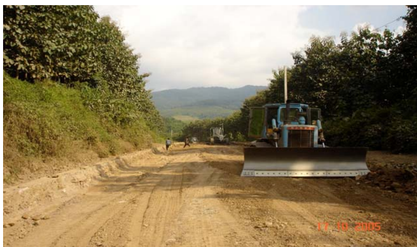
รูปที่ 7.15 สภาพการก่อสร้างเส้นทาง R3E ช่วงที่ 1
