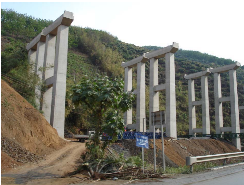
รูปที่ 7.33 เส้นทางที่กำลังก่อสร้างช่วงเมืองเชียงรุ่ง-ซือเหมา
