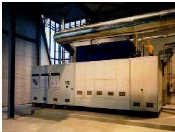
รูปที่ 33 เครื่องผลิตกระแสไฟฟ้าแบบ Tubular Solid Oxide โดย Siemens Westinghouse (ที่มา www.moea.state.mn.us.htm )
