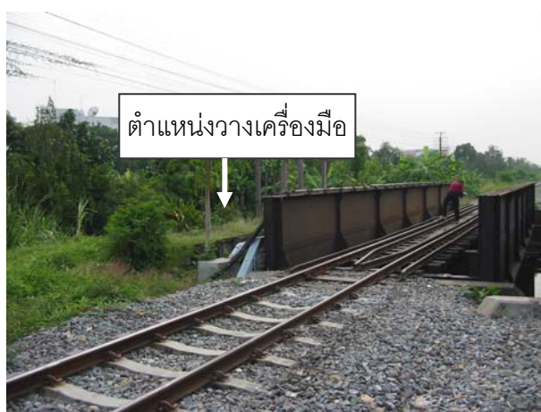
ภาพที่ 3-16 ตำแหน่งการจัดวางเครื่องมือของสะพานใกล้สถานีรถไฟบางบำหรุ
