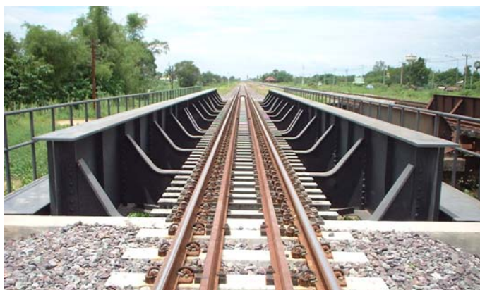
ภาพที่ 2-3 สะพานแม่แควเหล็กแผ่นขึ้น (ทวิ ทองปาน, 2537)
