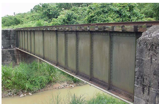
ภาพที่ 2-2 สะพานแม่แควเหล็กแผงลง (ทวิ ทองปาน, 2537)
