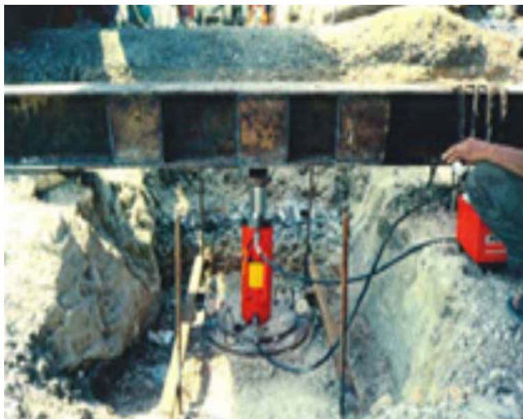
ภาพที่ 2.18 การทดสอบด้วย วิธี Pile Load Test
