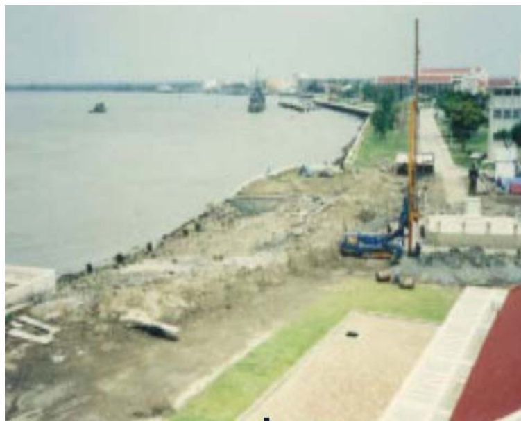
ภาพที่ 2.19 การสร้างกำแพงกันตลิ่งริมแม่น้ำเจ้าพระยา
