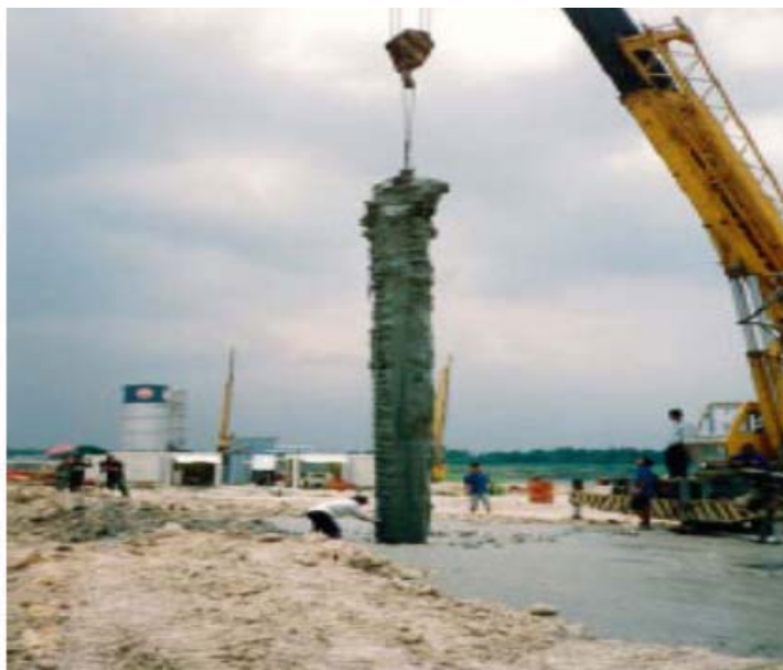
ภาพที่ 2.13 การทดสอบเสาเข็มดินซีเมนต์
