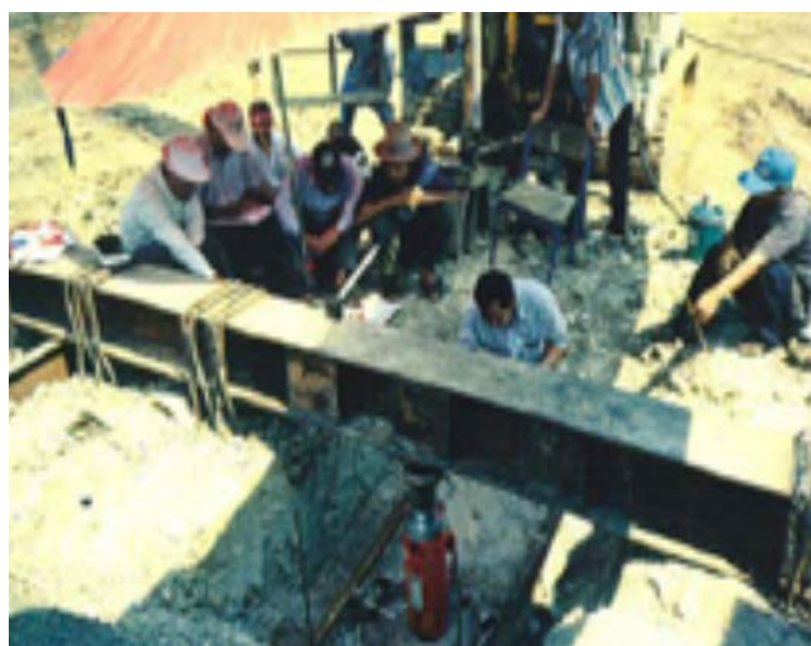
ภาพที่ 2.17 การทดสอบด้วยวิธี Pile Load Test
