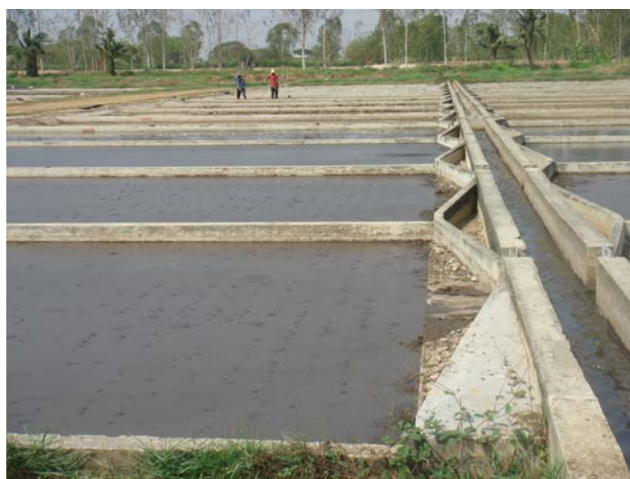
รูปที่ 28 ลักษณะการตากตะกอนน้ำเสียปนมูลสุกร (Sludge) ในลานกลางแจ้ง
