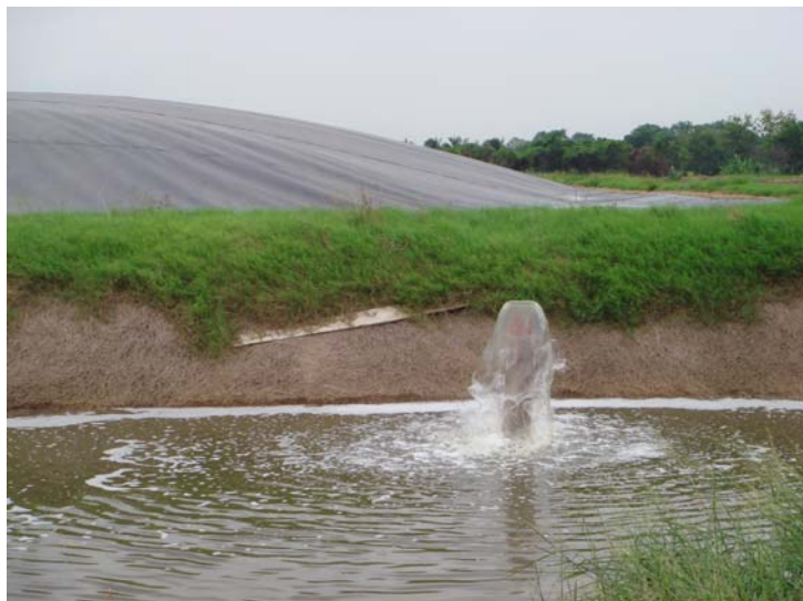
รูปที่ 26 ตำแหน่งที่เก็บตัวอย่างน้ำเสีย หลังออกจากถังแก๊ส
