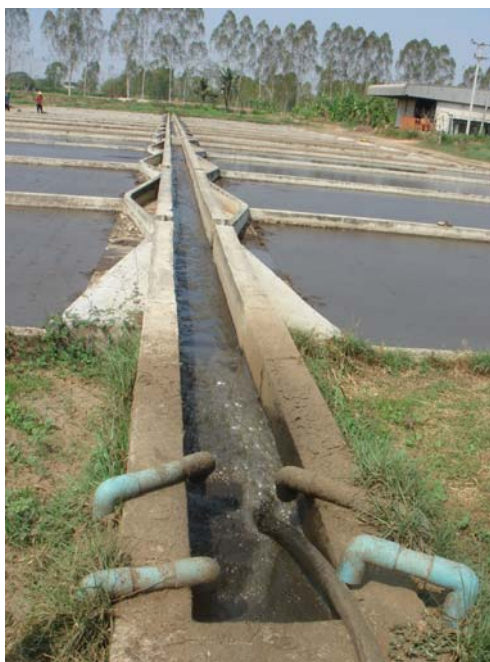
รูปที่ 27 ภาพแสดงการผัน Sludge ตำแหน่งสุดท้ายหลังจากออกจากถังแก๊ส เพื่อทำการตากในลานตากมูลสุกร
