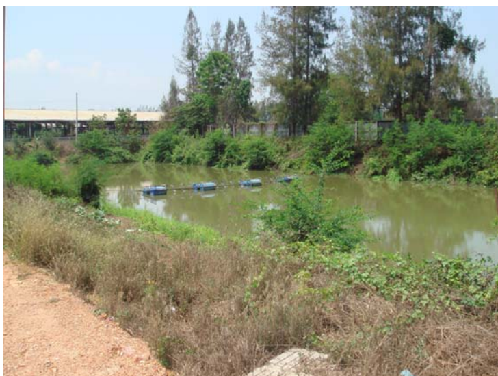
รูปที่ 20 บ่อน้ำดิบที่ฟาร์มสุกรใช้ ก่อนบำบัดด้วยคลอรีนและจ่ายไปตามท่อในฟาร์ม
