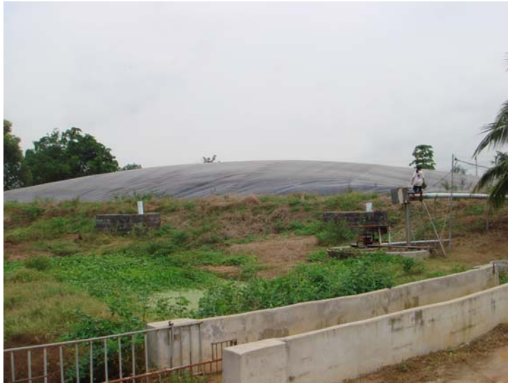
รูปที่ 23 สำหรับฟาร์มที่ติดตั้งระบบ Biogas system ภายในฟาร์ม
