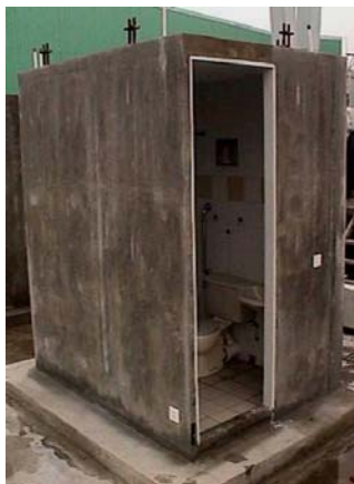
ภาพที่ 2.11 แสดงห้องน้ำสำเร็จรูประบบกล่อง ที่มา : ปรับปรุงจาก สามชัย รมทอง และ อานนท์ นันทฤชัย (2547)
