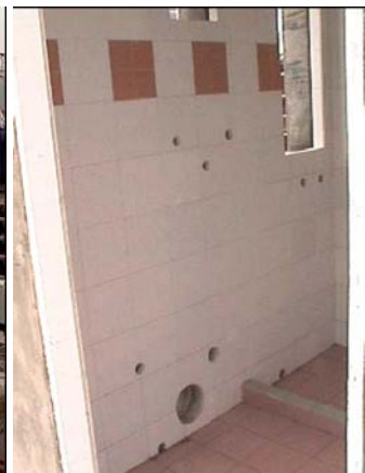
ภาพที่ 2.11 แสดงห้องน้ำสำเร็จรูประบบกล่อง ที่มา : ปรับปรุงจาก สามชัย รมทอง และ อานนท์ นันทฤชัย (2547)
