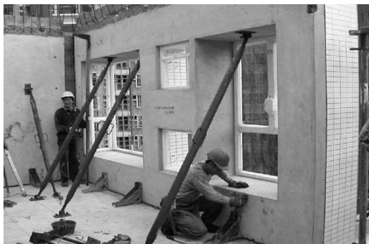
ภาพที่ 2.9 แสดงงานติดตั้งระบบขึ้นส่วนสำเร็จรูประบบแผ่น ที่มา : ปรับปรุงจาก สามชัย รมทอง และ อานนท์ นันทฤชัย (2547)
