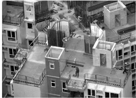
ภาพที่ 2.10 แสดงระบบขึ้นส่วนสำเร็จรูประบบกล่อง โครงการ ONE CENTRAL, MACAU 2006 ที่มา : ปรับปรุงจาก สามชัย รมทอง และ อานนท์ นันทฤชัย (2547)
