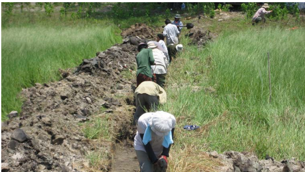
รูป ๔.๓๖ การขุดร่องสำรวจหาตะกอนสีนามิในอดีตบริเวณที่ลุ่มต่ำหลังแนวสันทรายบนเกาะพระทองเมื่อเดือนเมษายน ๒๕๕๐ (ภาพโดย รศ.ดร. มนตรี ชูวงศ์)
