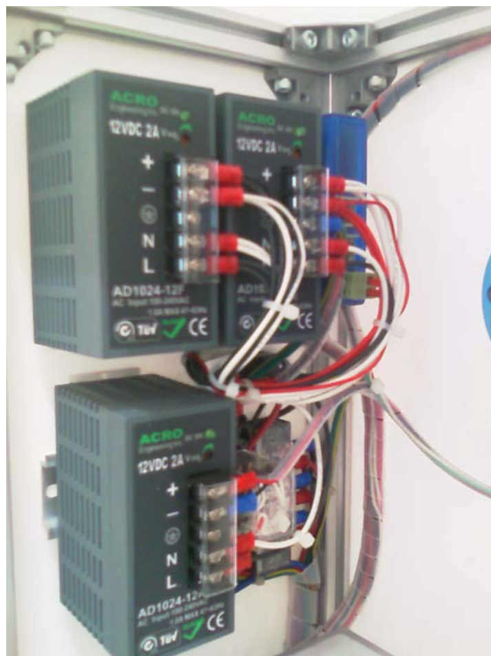
รูปที่ 4.4 รูปถ่ายของโมดูลแหล่งจ่ายไฟฟ้ากระแสตรง 12 โวลต์ ดีซี
