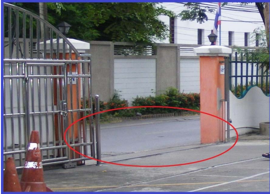
รูปที่ 15.13 ทางเข้าโรงเรียน เป็นซอยเล็ก ถนนขนาด 2 ช่องทางจราจร
