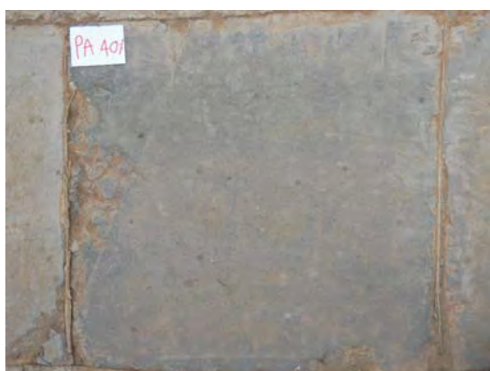
รูปที่ 29 สภาพพื้นคอนกรีต PA40 ในการทดสอบการใช้งานจริง ที่ระยะเวลา 1 และ 6 เดือน
