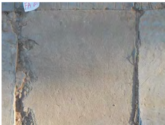
รูปที่ 27 สภาพพื้นคอนกรีต FA60 ในการทดสอบการใช้งานจริง ที่ระยะเวลา 1 และ 6 เดือน
