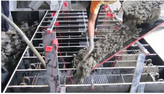
รูป 3.7 การเทคอนกรีตลงในแบบ และการแต่งผิวคอนกรีต
