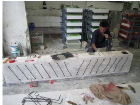
รูป 1.0.7 การซ่อมแซมคานเมื่อคานวิบัติภายใต้แรงเฉือน โดยการเสริมแผ่นเฟอร์โรซีเมนต์ด้านข้างคาน
