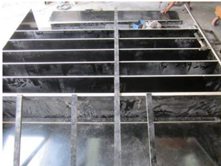
รูป 3.4 การเตรียมไม้แบบ(ไม้อัดดำขนาด 20 มม.) ให้ได้ขนาด 200x400x1600 มม.
