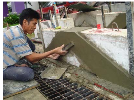
รูป 3.12 การซ่อมแซมคานเหล็กเมื่อคานลึกวิบัติภายใต้แรงเฉือนร่วมอัดโดยการเสริมแผ่นเฟอร์โรซีเมนต์
