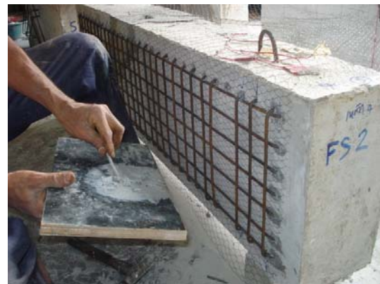
รูป 3.8 การซ่อมแซมคานเหล็กโดยการเสริมแผ่นเฟอร์โรซีเมนต์ด้านข้างคานเหล็ก
