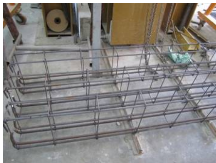
รูป 1.0.2 การจัดวางเหล็กของคานชุดสองวิบัติภายใต้แรงเฉือน (SB0, SB1, SB2)
