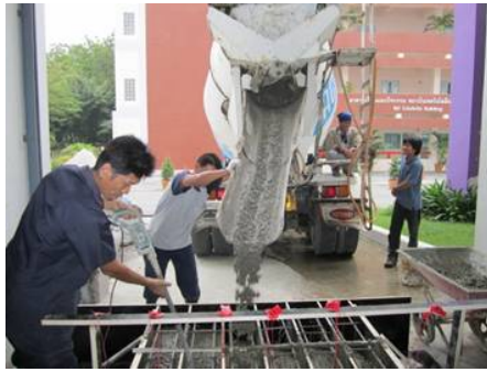
รูป 1.0.5 การเทคอนกรีตลงในแบบ และการตั้งผิวคอนกรีต
