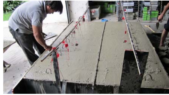
รูป 3.7 การเทคอนกรีตลงในแบบ และการแต่งผิวคอนกรีต
