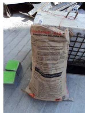
รูป 3.10 วัสดุที่ใช้ในการซ่อมแซมคานเหล็ก (Non-Shrink Grout)
