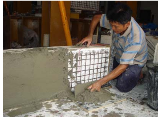
รูป 3.11 โดยการจัดวางแถบเฟอร์โรซีเมนต์ทั้งแนวนอนและแนวตั้ง SD3F, SS3F
