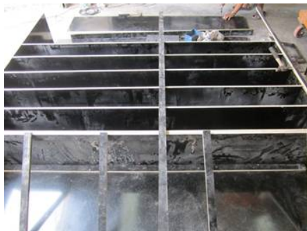
รูป 1.0.3 การเตรียมไม้แบบ(ไม้อัดดำขนาด 20 มม.) ให้ได้ขนาด 200x400x2400 มม.
