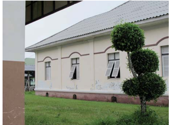
รูปที่ 3.104 มุมด้านข้างของอาคารเรียน โรงเรียนอุเทนวิทยาคาร อำเภอท่าอุเทน จังหวัดนครพนม
