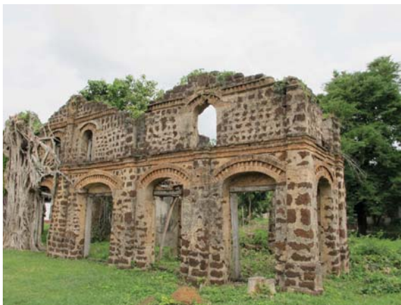
รูปที่ 3.93 โครงสร้างอาคารเรียงวัดดุศิลา แลงในการก่อสร้างอาคารแบบ อาณานิคม ในเมืองท่าแร่ จังหวัดสกลนคร
