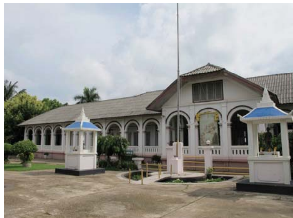
รูปที่ 3.105 มุมเฉียงทางทิศเหนือคือมุขหน้า ของโรงเรียนสุนทรวิจิตร อำเภอเมือง จังหวัดนครพนม
