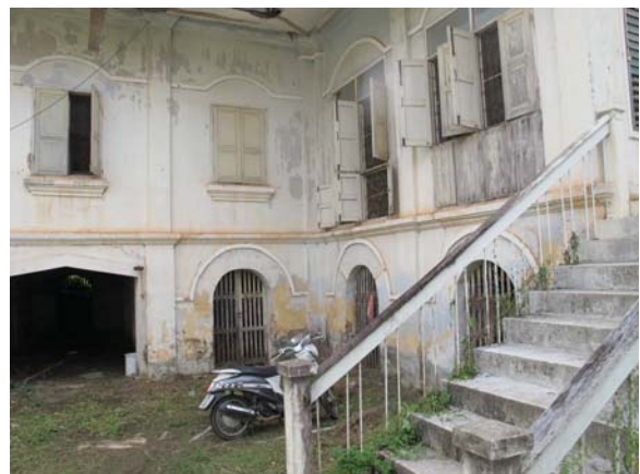
รูปที่ 3.115 รายละเอียดการตกแต่งหลังจาก การซ่อมแซม ศาลหลังเก่า ในอำเภอเมือง จังหวัดนครพนม
