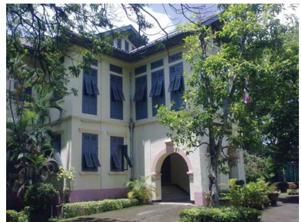
รูปที่ 3.83 จวนผู้ว่าสร้างในปี พ.ศ. 2472 อำเภอเมือง จังหวัดหนองคาย
