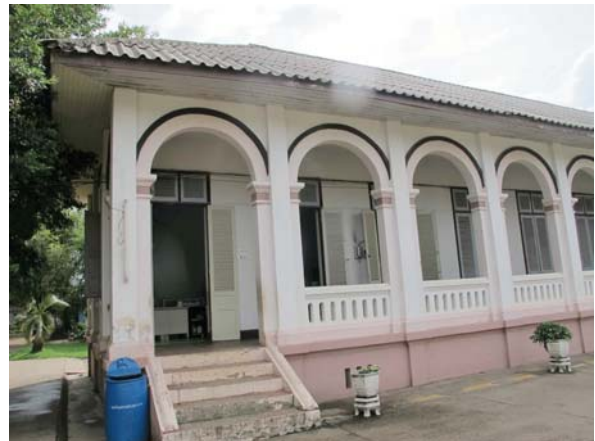
รูปที่ 3.106 บันไดทางขึ้นทางปีกของอาคาร ทางทิศใต้ ของโรงเรียนสุนทร วิจิตร อำเภอเมือง จังหวัดนครพนม
