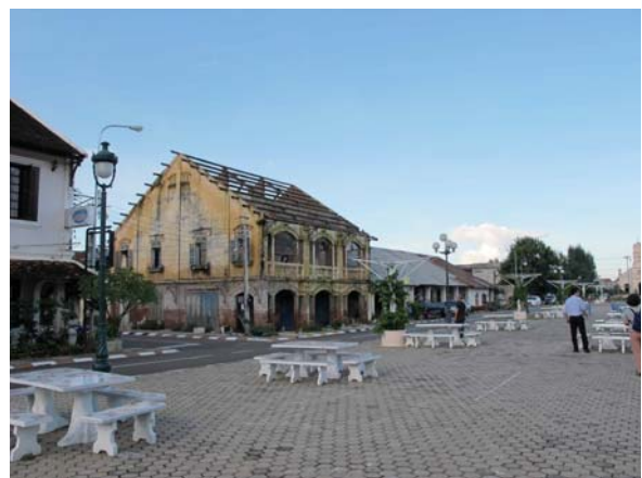
รูปที่ 3.63 ส่วนหนึ่งของอาคารกำลังรื้อ หลังคาเพื่อปรับปรุงใหม่ในเมือง สะหวันนะเขต สปป. ลาว
