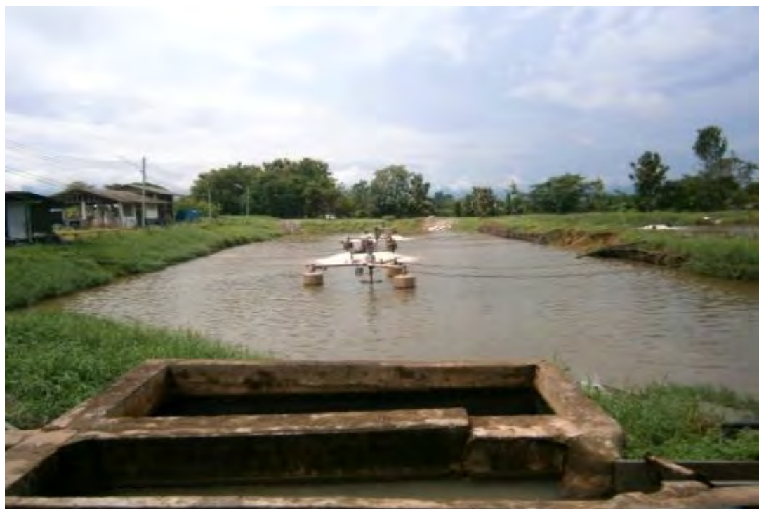
ภาพที่ 12 บำบัดน้ำเสียแบบเติมอากาศของโรงบำบัด WWTP 4
