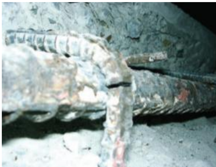
รูปที่ 2-6 ความเสียหายที่เกิดขึ้นในเหล็กปลอก (Miyagawa et al. , 2006)
