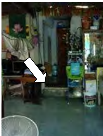
ภาพที่ 10 (ซ้าย) บ้านหลายหลังติดตั้งวัสดุทนน้ำ เช่น แผ่นเรียบ เพื่อป้องกันน้ำเข้าบ้าน (กลาง) เมื่อมีการต่อเติมปรับปรุงภายในเจ้าของบ้านทำการยกพื้นในส่วนที่ทำใหม่ ส่วนพื้นเดิมต้องรอเก็บเงินให้พอต่อการก่อสร้าง (ขวา) บ้านบางแห่งทำการยกพื้นทั้งหลังสูงกว่าทางเดินชุมชน โดยอยู่ในระดับที่สูงกว่าระดับน้ำที่ท่วมเป็นประจำ ที่มา: ถ่ายภาพโดยคณะผู้วิจัย
