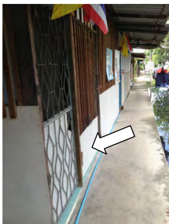
ภาพที่ 10 (ซ้าย) บ้านหลายหลังติดตั้งวัสดุทนน้ำ เช่น แผ่นเรียบ เพื่อป้องกันน้ำเข้าบ้าน (กลาง) เมื่อมีการต่อเติมปรับปรุงภายในเจ้าของบ้านทำการยกพื้นในส่วนที่ทำใหม่ ส่วนพื้นเดิมต้องรอเก็บเงินให้พอต่อการก่อสร้าง (ขวา) บ้านบางแห่งทำการยกพื้นทั้งหลังสูงกว่าทางเดินชุมชน โดยอยู่ในระดับที่สูงกว่าระดับน้ำที่ท่วมเป็นประจำ ที่มา: ถ่ายภาพโดยคณะผู้วิจัย
