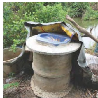
ภาพที่ 2 (ซ้าย) ยกเครื่องเรือนพื้นน้ำโดยใช้บล็อกคอนกรีตที่เตรียมไว้ในการทำกำแพงกันน้ำ (กลาง) ใช้ยางรถยนต์รองแผ่นไม้เป็นทางเดินติดต่อระหว่างบ้าน (ขวา) ส้วมชั่วคราวยกสูงระหว่างน้ำท่วมที่คลองบึงไผ่
