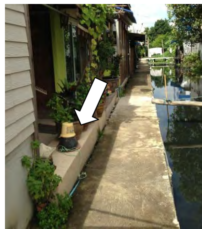
ภาพที่ 3 (ซ้าย) บ้านหลายหลังติดตั้งวัสดุทึบน้ำเพื่อป้องกันน้ำเข้าบ้าน (กลาง) เมื่อมีการต่อเติมปรับปรุงภายใน เจ้าของบ้านทำการยกพื้นในส่วนที่ทำใหม่ ส่วนพื้นเดิมต้องรอเก็บเงินให้พอต่อการก่อสร้าง (ขวา) เจ้าของบ้านทำการยกพื้นหลังสูงกว่าทางเดินชุมชน โดยอยู่ในระดับที่สูงกว่าระดับน้ำที่ท่วมเป็นประจำ
