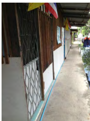
ภาพที่ 3 (ซ้าย) บ้านหลายหลังติดตั้งวัสดุทึบน้ำเพื่อป้องกันน้ำเข้าบ้าน (กลาง) เมื่อมีการต่อเติมปรับปรุงภายใน เจ้าของบ้านทำการยกพื้นในส่วนที่ทำใหม่ ส่วนพื้นเดิมต้องรอเก็บเงินให้พอต่อการก่อสร้าง (ขวา) เจ้าของบ้านทำการยกพื้นหลังสูงกว่าทางเดินชุมชน โดยอยู่ในระดับที่สูงกว่าระดับน้ำที่ท่วมเป็นประจำ
