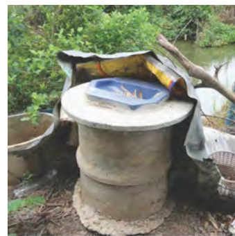
ภาพที่ 9 (ซ้าย) ยกเครื่องเรือนให้สูงกว่าระดับน้ำโดยใช้บล็อกคอนกรีตที่เตรียมไว้ในการทำกำแพงกันน้ำ (กลาง) ใช้ยางรถยนต์รองแผ่นไม้เป็นทางเดินติดต่อกันระหว่างบ้าน (ขวา) ยกสุขาชั่วคราวให้สูงระดับน้ำท่วมที่คลองบึงไผ่ ที่มา: วาดโดยคณะผู้วิจัย
