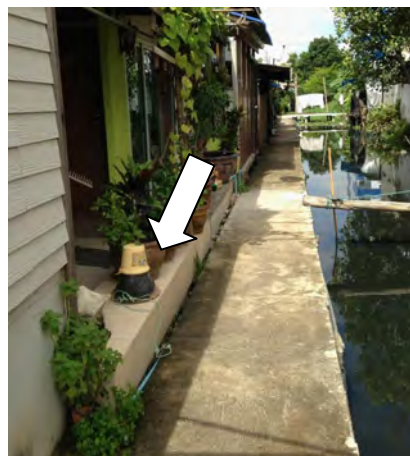
ภาพที่ 10 (ซ้าย) บ้านหลายหลังติดตั้งวัสดุทนน้ำ เช่น แผ่นเรียบ เพื่อป้องกันน้ำเข้าบ้าน (กลาง) เมื่อมีการต่อเติมปรับปรุงภายในเจ้าของบ้านทำการยกพื้นในส่วนที่ทำใหม่ ส่วนพื้นเดิมต้องรอเก็บเงินให้พอต่อการก่อสร้าง (ขวา) บ้านบางแห่งทำการยกพื้นทั้งหลังสูงกว่าทางเดินชุมชน โดยอยู่ในระดับที่สูงกว่าระดับน้ำที่ท่วมเป็นประจำ ที่มา: ถ่ายภาพโดยคณะผู้วิจัย
