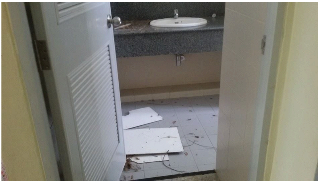
รูปที่ 4 การติดตั้งฝ้าเพดานโดยมีเหล็กตัว T และใช้หมุดยึดกับคานคอนกรีตเสริมเหล็ก ฝ้าเพดานร่วงหล่นลงมาบริเวณชั้นสองของอาคารแพทย์แผนไทย
