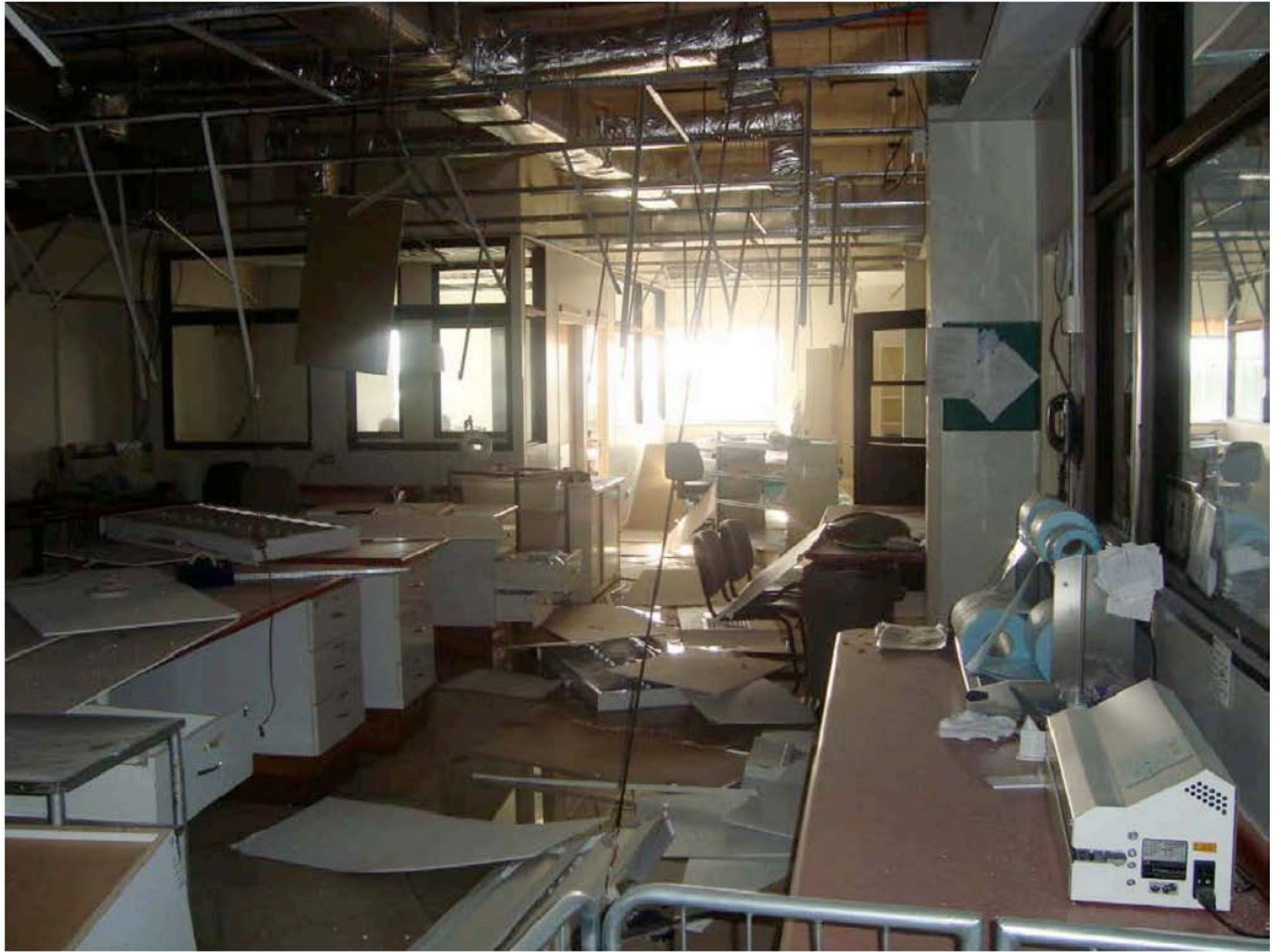
รูปที่ 5 สภาพความเสียหายของฝ้าเพดาน และ ระบบหลอดไฟฟ้า และ ระบบระบายอากาศที่โรงพยาบาล Los Angeles เนื่องจากแผ่นดินไหวขนาด 8.8 ที่ประเทศชิลีเมื่อปี พ.ศ. 2553
