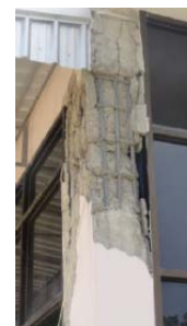
(ค) เสามุมด้านหลังวิบัติรุนแรง
