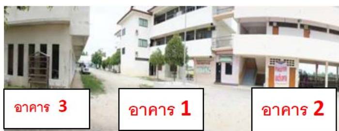
รูปที่ 2.24 อาคารคอนกรีตเสริมเหล็ก 3 หลังในโรงเรียนวัดเหมืองง่าพิเศษวิทยาอำเภอบ้านจั่นจังหวัดเชียงรายที่เกิดความเสียหายแตกต่างกัน (ปณิธาน ลักคุณะประสิทธิ์, 2557)
