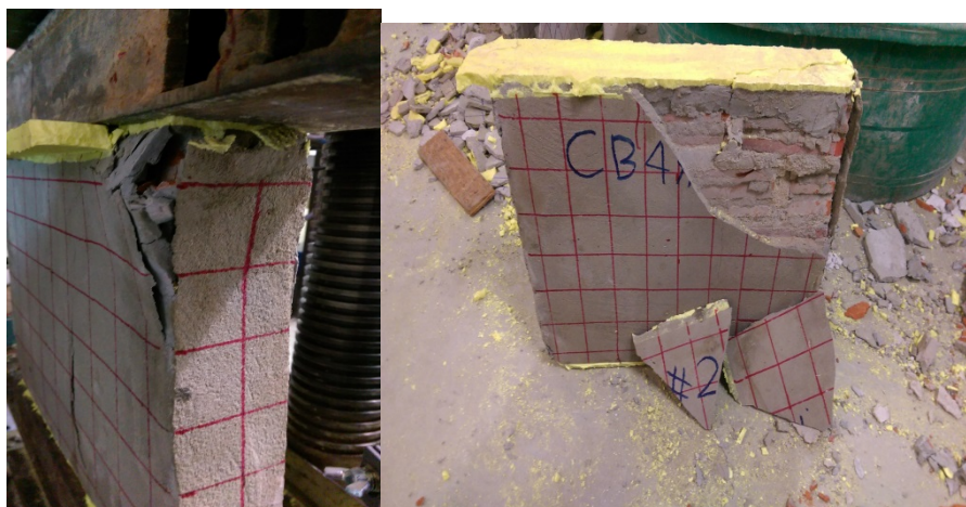
รูปที่ 3.21 ลักษณะการวิบัติของชิ้นส่วนผนังก่ออิฐมวลเบาชนิดที่ 4 (CB4)
