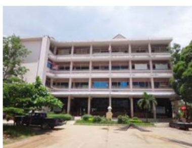
(ก) อาคาร คสล. 4 ชั้น
