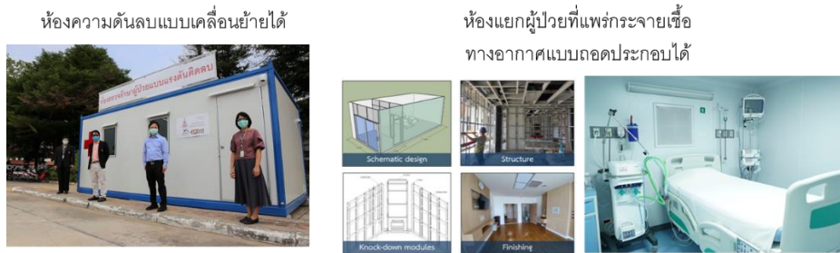
รูปแบบที่ 44 ห้องความดันติดลบแบบเคลื่อนย้ายได้ และห้องแยกผู้ป่วยที่แพร่กระจายเชื้อทางอากาศแบบถอดประกอบได้
