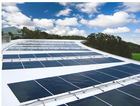
รูปที่ 3-12 เซลล์แสงอาทิตย์ฟิล์มบางชนิด CIGS แบบประยุกต์เป็นหลังคาโซลาร์กับผนังโซลาร์ (ที่มา: https://www.sunergistgroup.com/TH/product.html )
