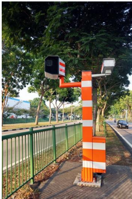
รูปที่ 3.11 กล้องตรวจจับความเร็วแบบติดตั้งถาวร
