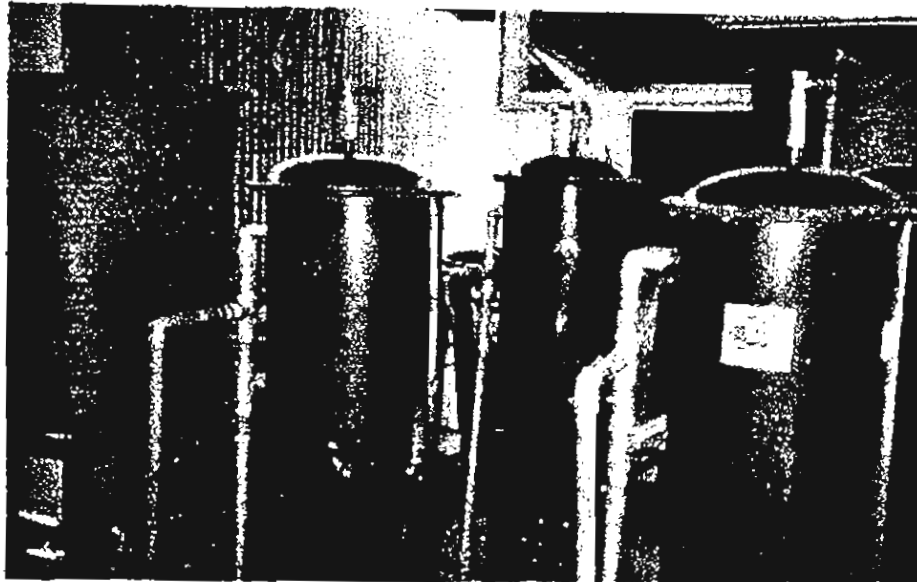
รูปที่ 4-4 ถังตกตะกอน
