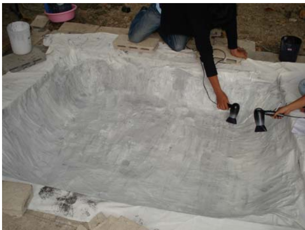
รูปที่ 34 ลักษณะสระที่ทำนํ้ายางทับผ้าเรียบร้อยขณะฝนลมร้อน
