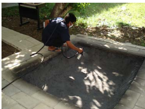
รูปที่ 35 การพ่นรอบแรกและการทาทับล้างจากการปูผ้า
