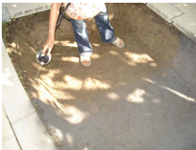
รูปที่ 33 การพ่นสเปรย์น้ำยางลงบนดินก่อนที่จะปูผ้าและฉาบยาง
