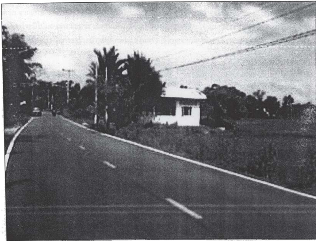
ภาพที่ 3 แสดงถนนคอนกรีตในหมู่บ้านชูงบาริระ ตำบลกายูบอเกาะ อำเภอรามัน จังหวัดยะลา
