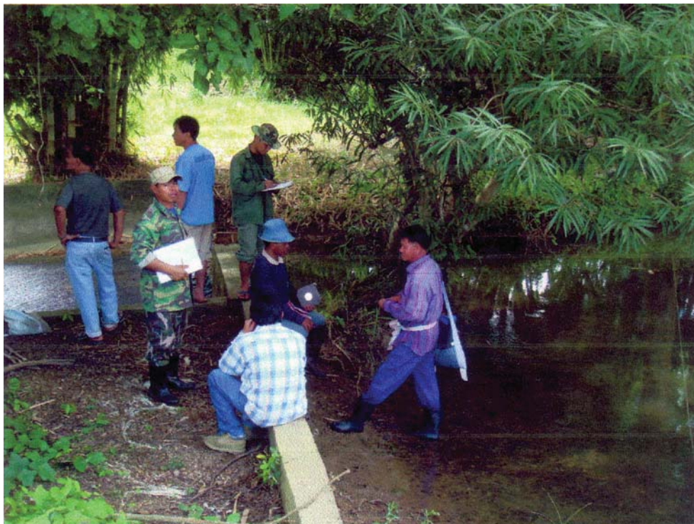
สภาพฝายหน้าบ้าน หมู่ที่ 13 เป็นฝายคอนกรีต ในภาพทีมวิจัยกำลังเก็บข้อมูล
