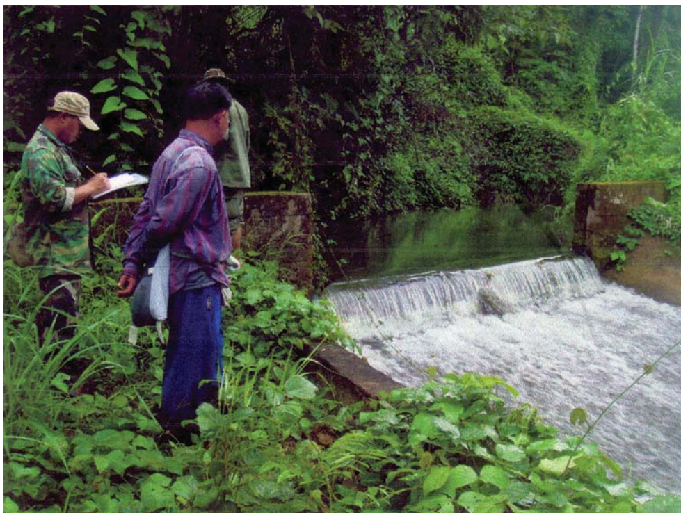
สภาพน้ำและฝายทุ่งเตาปูน มีสายน้ำไหลแรงมาก
