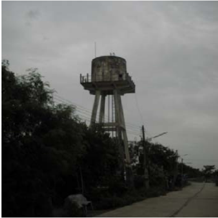
ภาพที่ 25 ระบบประปาหมู่บ้านผลิตจากน้ำบาดาล
