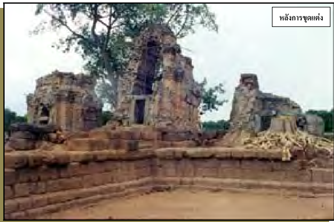
หลังการขุดแต่ง (ภาพ: ตุลาคม 2545)
