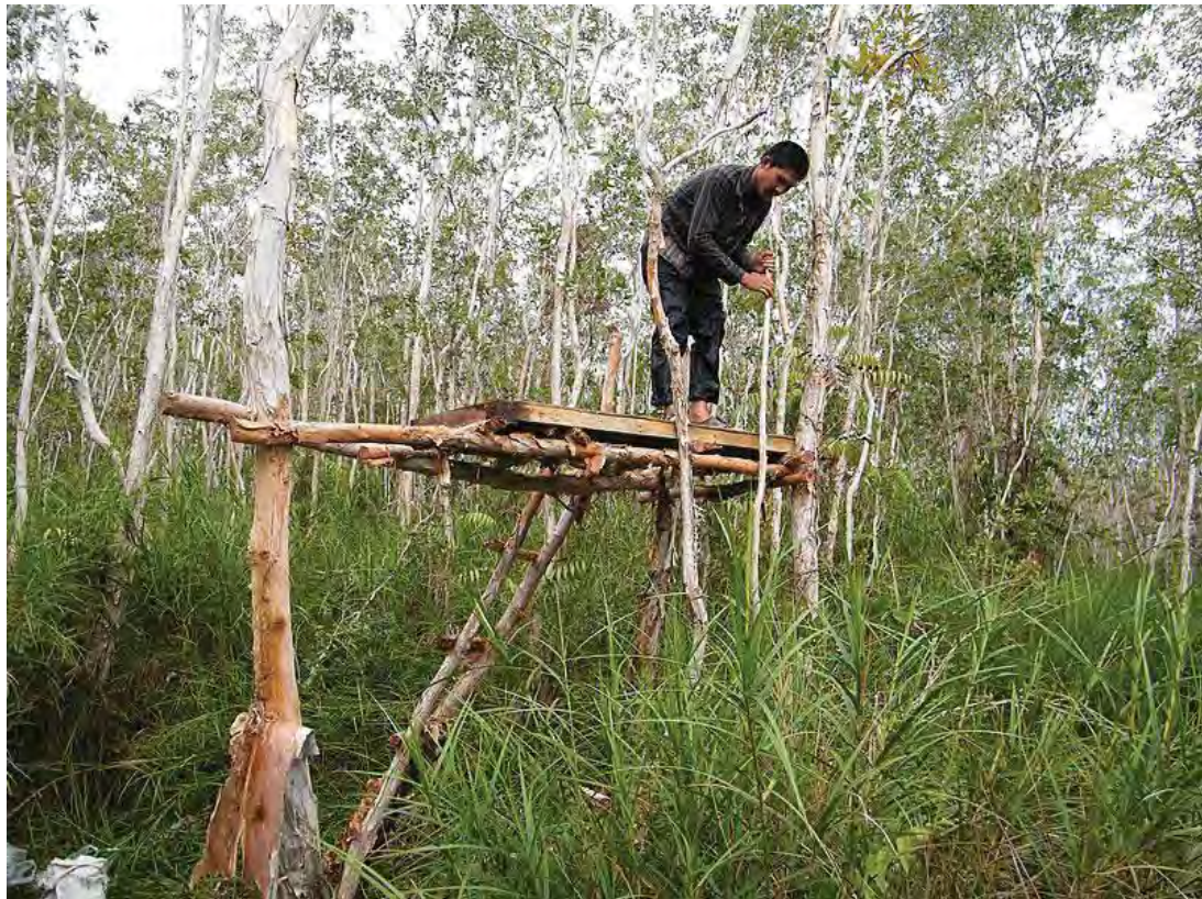
ภาพตัดไม้เสม็ดทำหำงและสะพานเชื่อม
