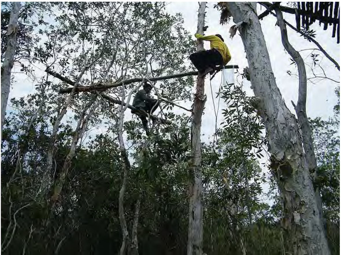
ภาพการสร้างห้างร้านที่ 1 และสะพานเชื่อม
