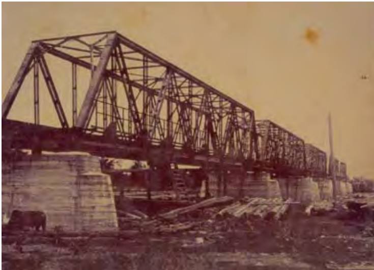
ภาพที่ 2.8 สะพานข้ามแม่น้ำวัง ใกล้สถานีรถไฟนครลำปาง หรือ ที่เรียกกันว่า "สะพานดำ" [ที่มา : หอจดหมายเหตุแห่งชาติ]
