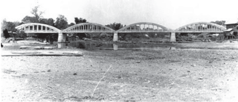
ภาพที่ 2.4 สะพานรัชฎาภิเศก โครงสร้างคอนกรีตเสริมเหล็ก สร้างเมื่อพ.ศ. 2460 [ที่มา : หอจดหมายเหตุแห่งชาติ]
