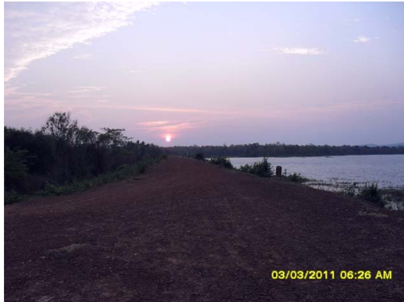
อาคารทำนบกั้น อ่างเก็บน้ำห้วยวังถ้ำ
