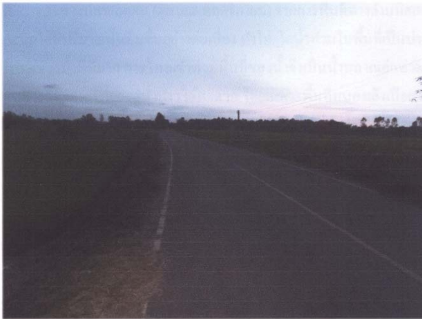
ภาพที่ 4.8 แนวถนนสายคอนกรีต – โกล่ลุ่ม ที่ยกระดับสูงกว่าพื้นที่เดิมทำให้เกิดขวางทางไหลของน้ำ
