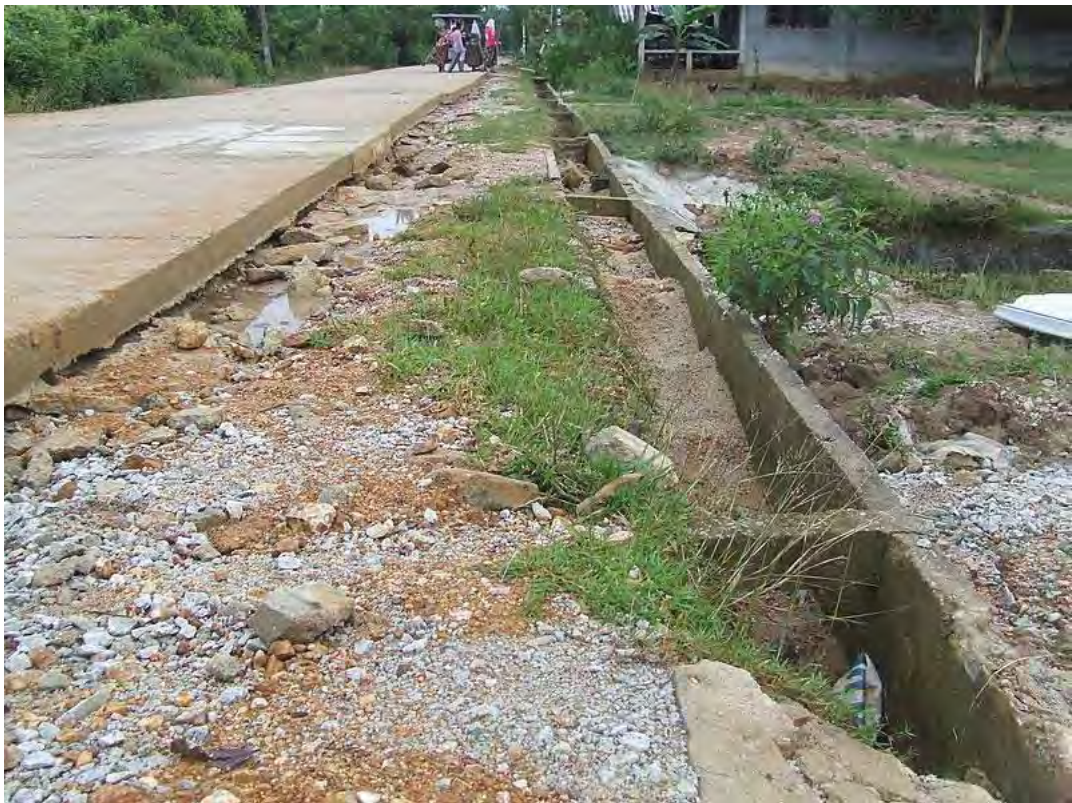
ถนนซีเมนต์ (ฝั่งซ้าย) ที่ปรับปรุงแล้ว เปรียบเทียบกับสภาพถนนเดิมที่เป็นหินคลุก
