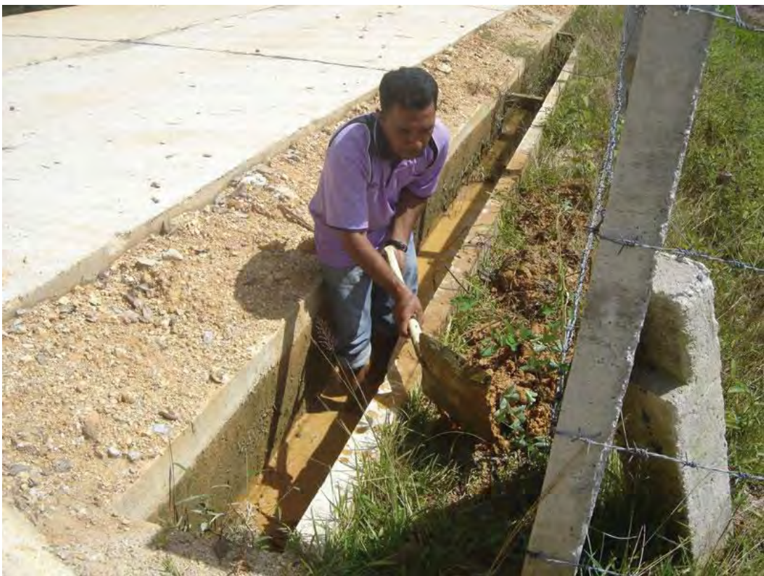
ชุดลอกคลองส่งน้ำชลประทานรอบสอง รองรับฤดูฝนและการทำนา วันที่ 20 ตุลาคม 2553 ณ แนวคลองส่งน้ำจากสถานีสูบน้ำ บ้านบุเกี๋ยนุง ตำบลลำภู อำเภอมือง จังหวัดนราธิวาส
