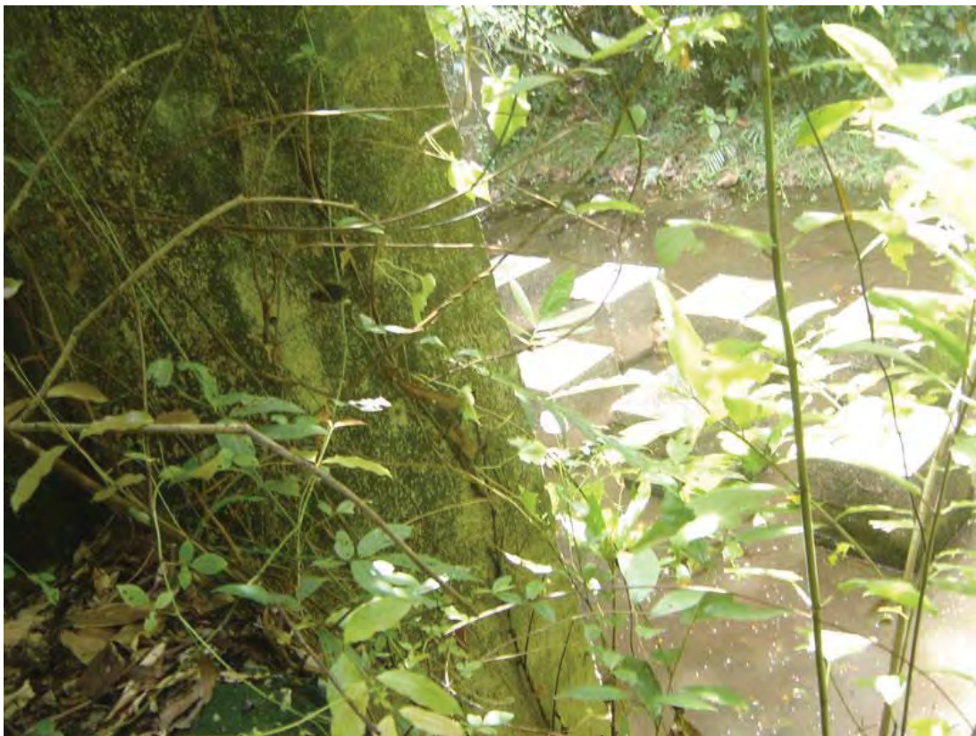
สำรวจปัญหาฝายน้ำล้นกันทางระบายน้ำ ส่งผลให้น้ำท่วมขัง วันที่ 20 ตุลาคม 2553 ณ สวนผลไม้ ตำบลลำภู อำเภอเมือง จังหวัดนราธิวาส
