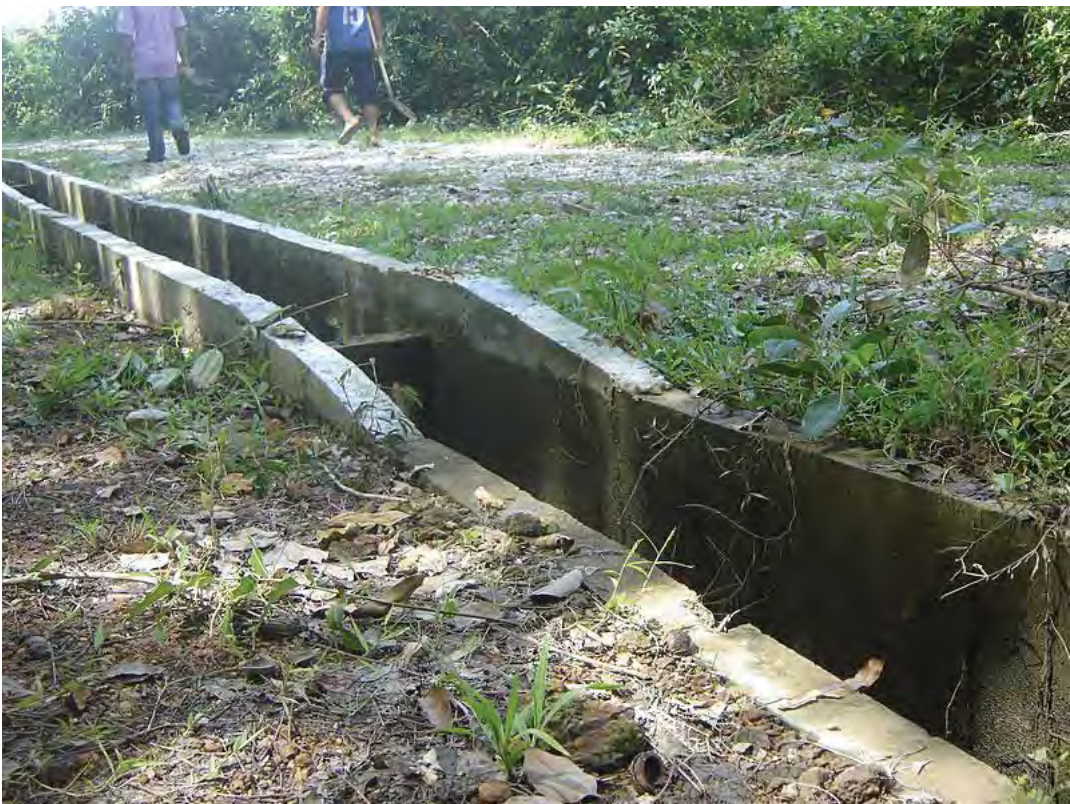
แนวคลองชลประทานที่ก่อซีเมนต์เสริมคันให้สูงขึ้น
