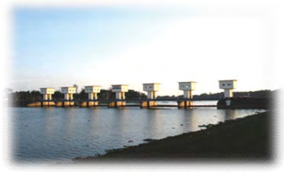
ประตูระบายน้ำบางนราตอนบน
