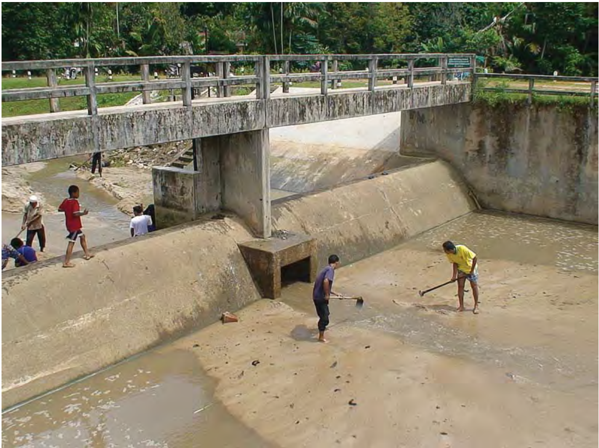
การขุดตะกอนทรายหน้าฝายกาเต็ง
