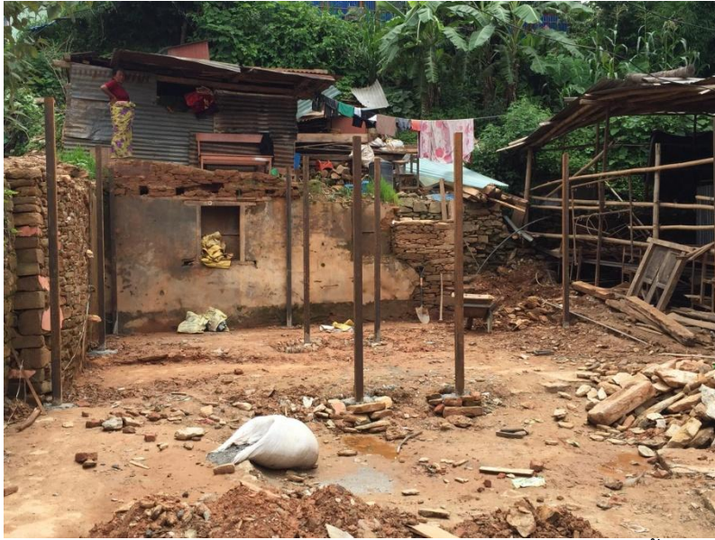
รูปที่ 67 การก่อสร้างบ้านอิฐก่อคล้ายเดิมแต่มีการเพิ่มเสาเหล็กกล่อช่วยรับน้ำหนักของหลังคา
