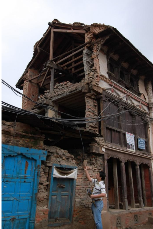
รูปที่ 27 โครงสร้างผนังรับแรงแบบอิฐดินเผาก่อด้วยโคลนทราย ซึ่งใช้ร่วมกับการก่ออิฐดินเผาภายนอกที่ใช้ปูนทราย เป็นวัสดุประสานเพื่อความคงทนต่อสภาพอากาศระบบพื้นใช้การถ่ายแรงผ่านตง
