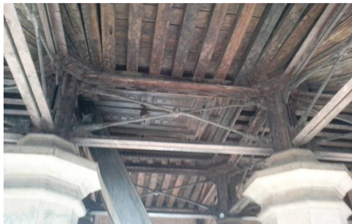
รูปที่ 88 ลักษณะการเสริมกำลังของอาคาร Chyasilin Mandap
