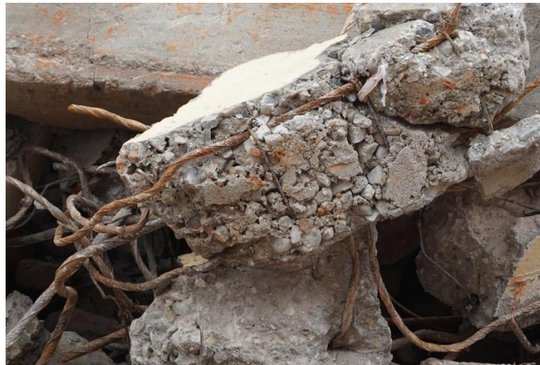
รูปที่ 95 ลักษณะการก่อสร้างอาคารด้วยวัสดุที่ไม่มีคุณภาพ
