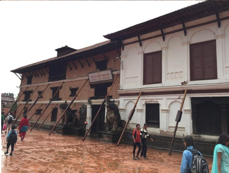
รูปที่ 61 ผนังอิฐของโบราณสถานที่เมือง Bhaktapur มีการค้ำยันเพื่อช่วยเพิ่มเสถียรภาพด้วยไม้
