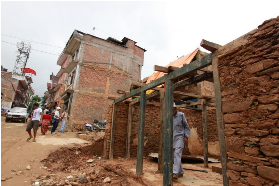
รูปที่ 18 ระบบกำแพงรับแรงที่ใช้ร่วมกับโครงสร้างไม้ในบริเวณที่ต้องมีการรับแรงดัด
