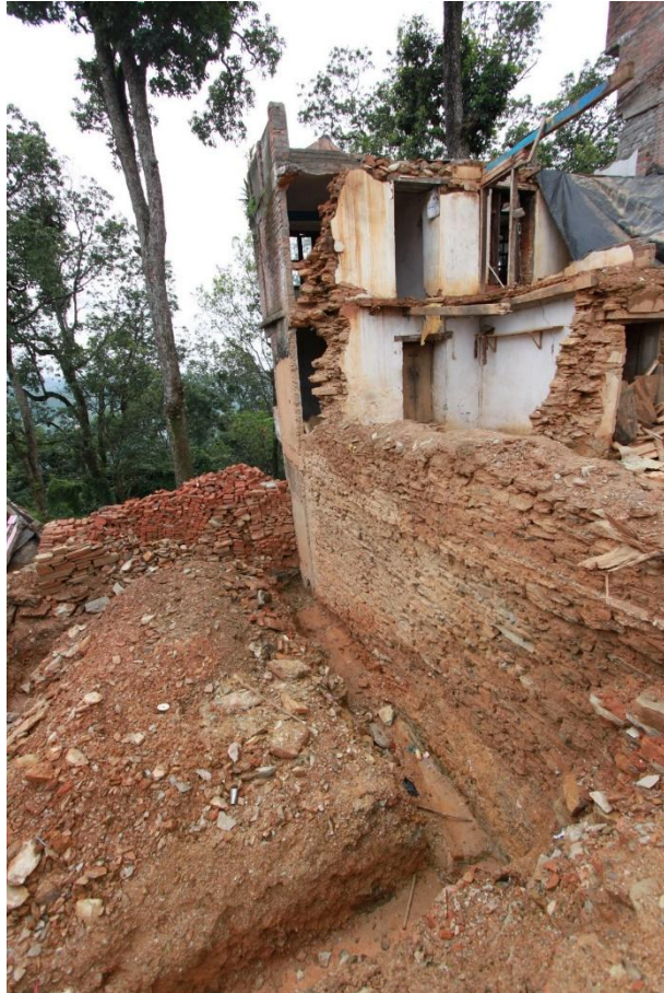
รูปที่ 19 ภาพแสดงระบบฐานรากของโครงสร้างกำแพงรับแรงซึ่งใช้วิธีการก่อกำแพงหินบนชั้นดินแข็ง ทางซ้ายมือของภาพคือลักษณะการขุดดินเพื่อเตรียมก่อสร้างฐานรากแบบตื้น ตามแนวกำแพงของอาคาร
