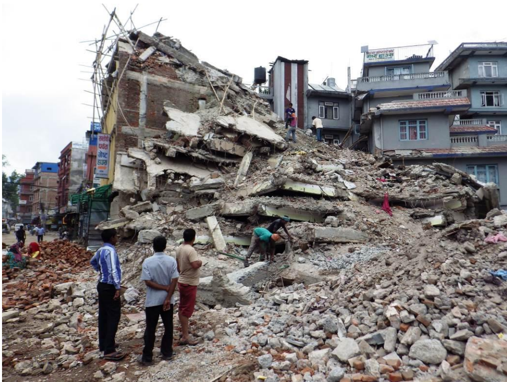
รูปที่ 5 ตัวอย่างอาคารที่คอนกรีตเสริมเหล็กพังถล่มในเขต Gongabu
