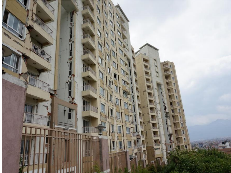
รูปที่ 96 อาคารสูงได้รับความเสียหายจากแผ่นดินไหว
