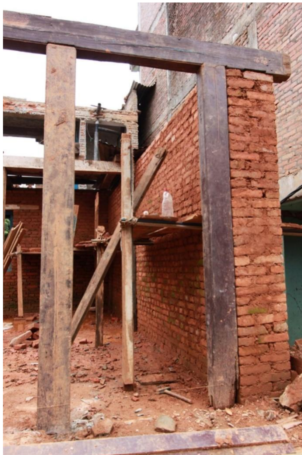
รูปที่ 26 ลักษณะการก่อกำแพงอิฐดินเผาซึ่งมีความหนาเท่ากับการก่ออิฐหนึ่งแผ่นครึ่ง
