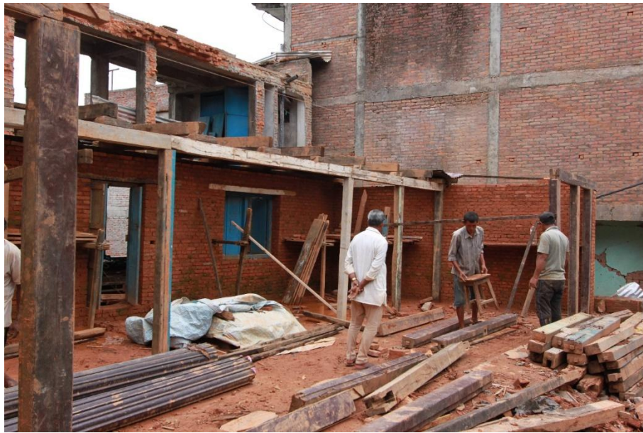
รูปที่ 25 การก่อสร้างโครงสร้างระบบกำแพงอิฐดินเผาพร้อมกับโครงสร้างไม้
