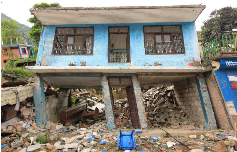
รูปที่ 34 ภาพแสดงการวิบัติแบบชั้นอ่อนในเขต Lamosanguh
