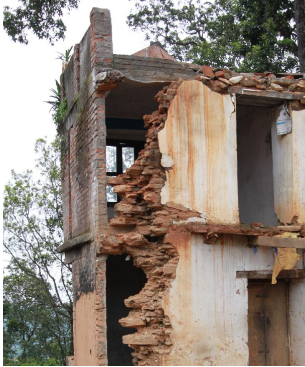
รูปที่ 20 การวิบัติภายในระนาบของกำแพงหินก่อรับแรง
