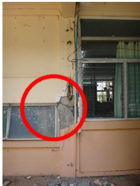
รูปที่ 38 การวิบัติแบบเฉือนในเสาทำให้เสาสูญเสียกำลังรับน้ำหนักแนวดิ่ง ซึ่งพบมากในประเทศไทยเมื่อเกิดแผ่นดินไหวแม่ลาว จังหวัดเชียงราย เมื่อปี 2557
