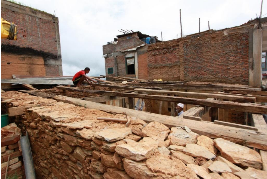
รูปที่ 17 ภาพแสดงวิธีการก่อกำแพงหินที่ใช้หินขนาดใหญ่ก่อให้ได้ระนาบที่เรียบด้านนอก ภายในใช้หินขนาดเล็กเรียงเติมเต็มช่องว่างร่วมกับโคลนทรายระบบพื้นชั้นที่อยู่เหนือระดับดินอาศัยการถ่ายแรงเข้าสู่กำแพงรับแรงผ่านโครงสร้างไม้ซึ่งรับแรงเฉือนและแรงดัด
