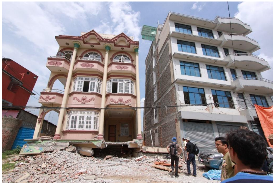
รูปที่ 36 ภาพแสดงการวิบัติแบบชั้นอ่อนในเขต Sithapaila
