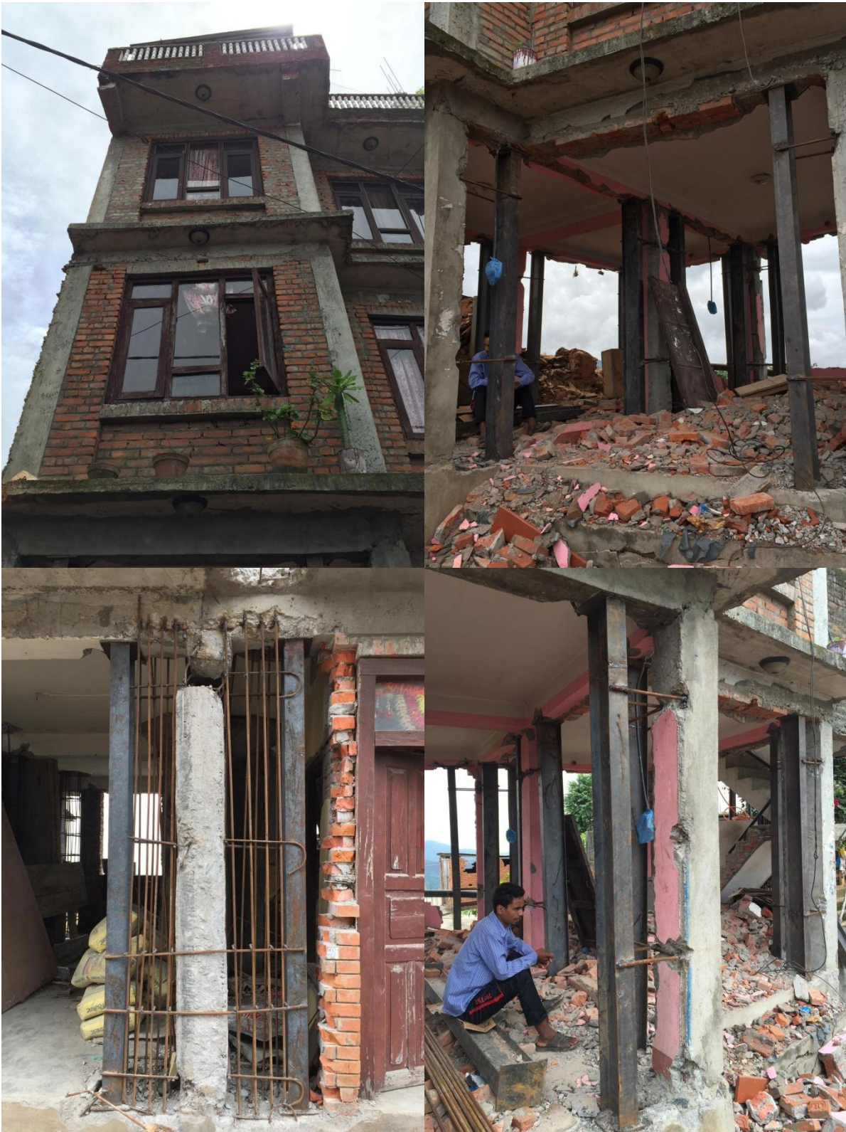
รูปที่ 72 อาคารที่เสียหายระดับปานกลางที่เจ้าของต้องการใช้งานต่อ ใช้วิธีซ่อมเสริมเสาด้วยเหล็ก H200 สองท่อน
