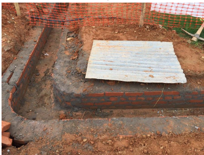
รูปที่ 79 พื้นที่โดยรอบมีการทำทางระบายน้ำไม่ให้น้ำท่วมขังพื้นที่โดยใช้อิฐ
