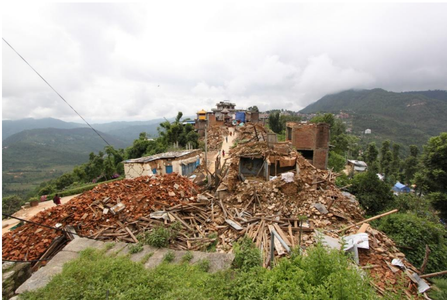
รูปที่ 23 ความเสียหายของโครงสร้างกำแพงหินก่อรับแรง (พื้นที่ด้านขวามือของภาพ)
