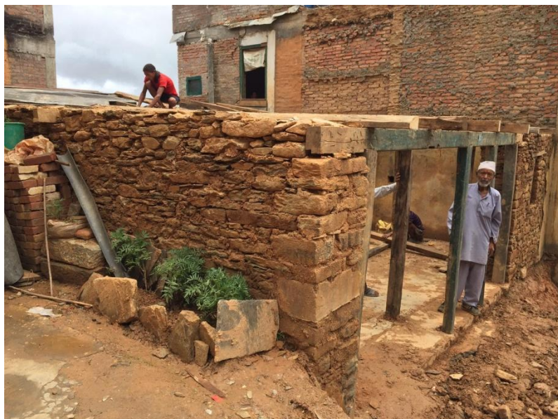
รูปที่ 70 การก่อสร้างบ้านหินก่อเหมือนรูปแบบเดิม
