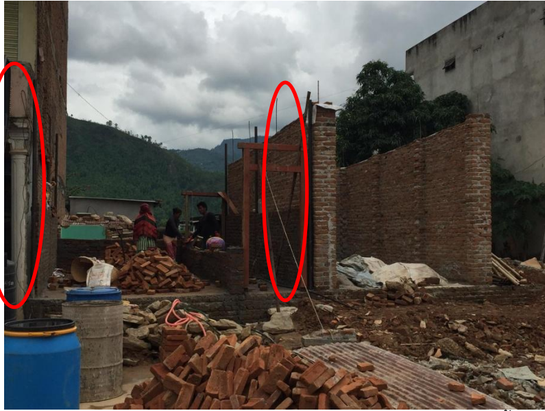
รูปที่ 69 การก่อสร้างบ้านอิฐก่อคล้ายเดิมแต่มีการเพิ่มเสาท่อนเหล็กกลมช่วยรับน้ำหนักของหลังคา
