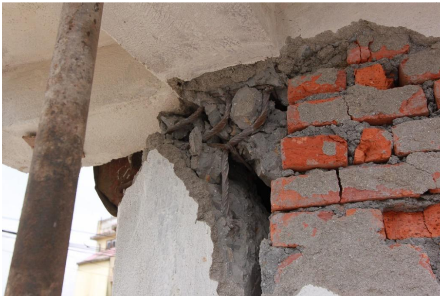
รูปที่ 42 ภาพขยายเสาบริเวณมุมด้านบนที่เกิดแรงต้านทานในแนวเฉียงจากกำแพงอิฐก่อ โดยรูปแบบการวิบัติของเสาเป็นการวิบัติจากแรงเฉือน (ระนาบการเสียหายของเสาเป็นแนวเฉียงบนระนาบของหน่วยแรงดึงสูงสุด)
