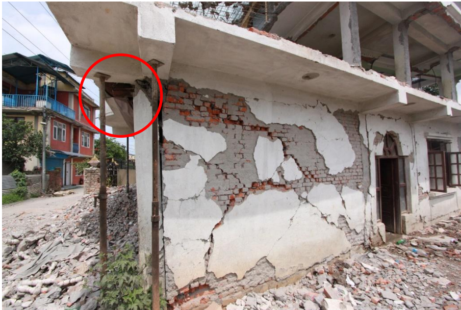
รูปที่ 41 การวิบัติของเสาจากแรงเฉือนบริเวณใกล้มุมอันเนื่องจากการต้านทานแรงดัดข้างของโครงข้อแข็งร่วมกับผนังอิฐ ในเขต Sithapaila
