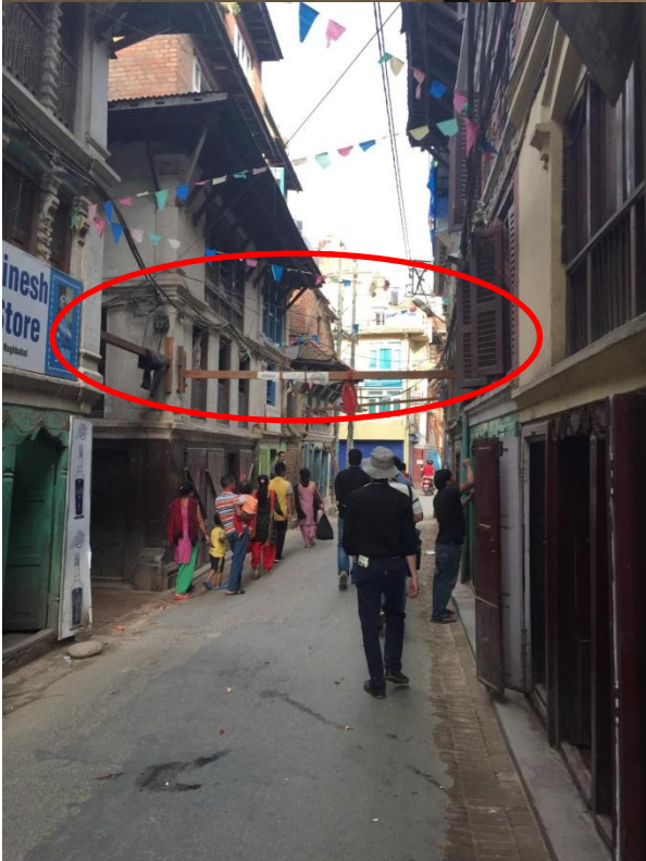
รูปที่ 63 ถนนตึกแถวใกล้ Patan Durbar Square มีการค้ำยันเพื่อช่วยเพิ่มเสถียรภาพด้วยไม้ทั้งแบบค้ำยันทแยงจากพื้นและค้ำยันกับอาคารฝั่งตรงข้าม
