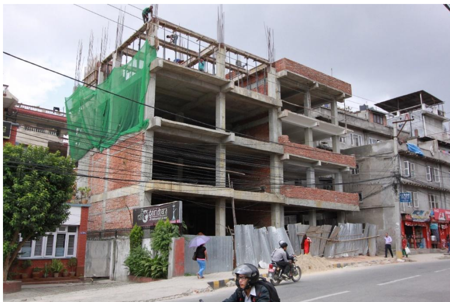
รูปที่ 29 โครงสร้างคองกรีตเสริมเหล็กที่ใช้ผนังเป็นกำแพงอิฐดินเผาก่อด้วยปูนทรายภายในกรุงเทพมหานคร
