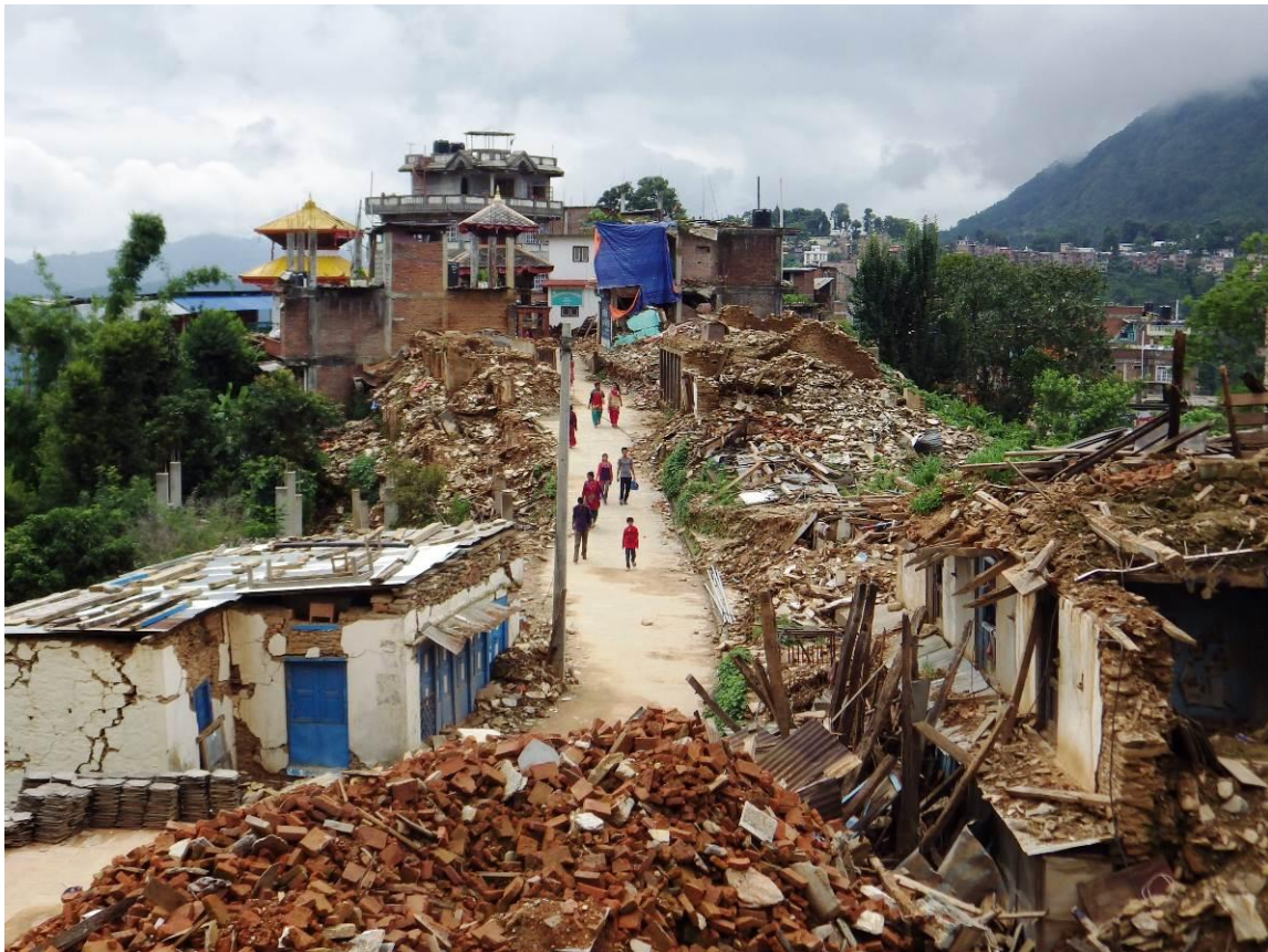
รูปที่ 7 การพังถล่มของอาคารจำนวนมากที่ตั้งอยู่ริมทางลาดเชิงเขาในเมือง Chautara
