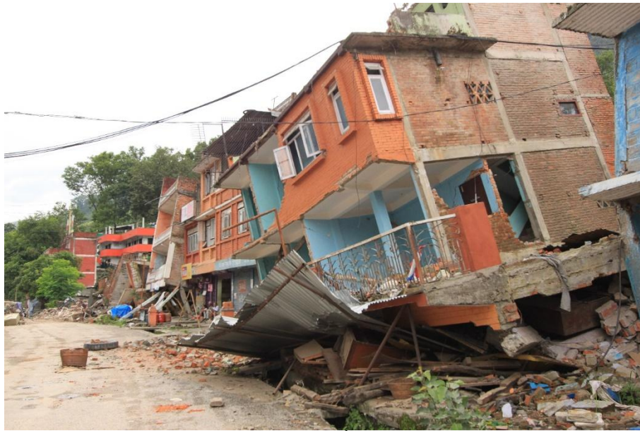
รูปที่ 35 ภาพแสดงการวิบัติแบบชั้นอ่อนในเขต Lamosanghu
