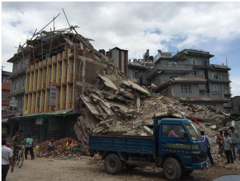
รูปที่ 66 การขนส่งเศษวัสดุไปทิ้งด้วยรถบรรทุก
