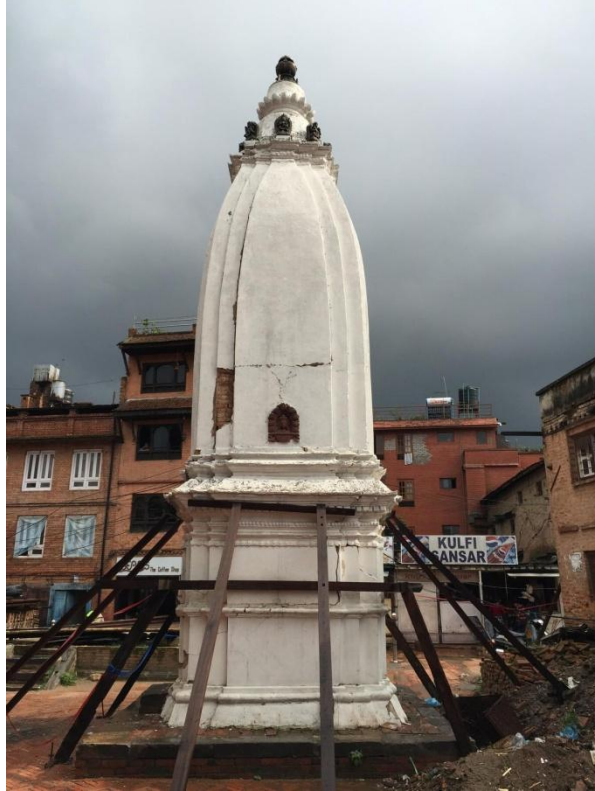
รูปที่ 62 ผนังอิฐของโบราณสถานที่เมือง Bhaktapur มีการค้ำยันเพื่อช่วยเพิ่มเสถียรภาพด้วยไม้
