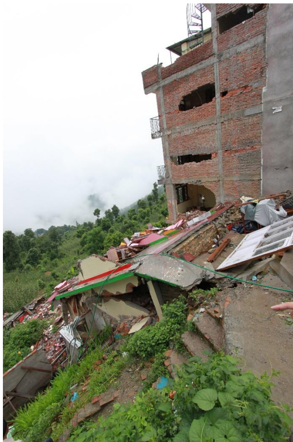
รูปที่ 55 อาคารที่พังทลายลงอย่างสิ้นเชิง ในเขต Sangachok โดยสันนิษฐานว่าเกิดจากกลไกการวิบัติของโครงข้อแข็งที่มีพฤติกรรมการต้านทานแรงด้านข้างที่ไม่สมมาตร
