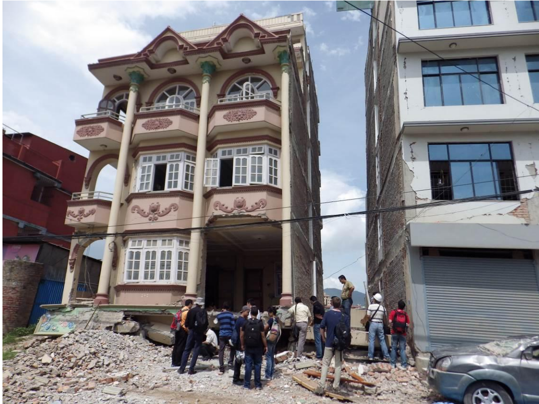
รูปที่ 4 อาคารที่มีชั้นล่างพังและพังลงไปทางซ้ายมือ
