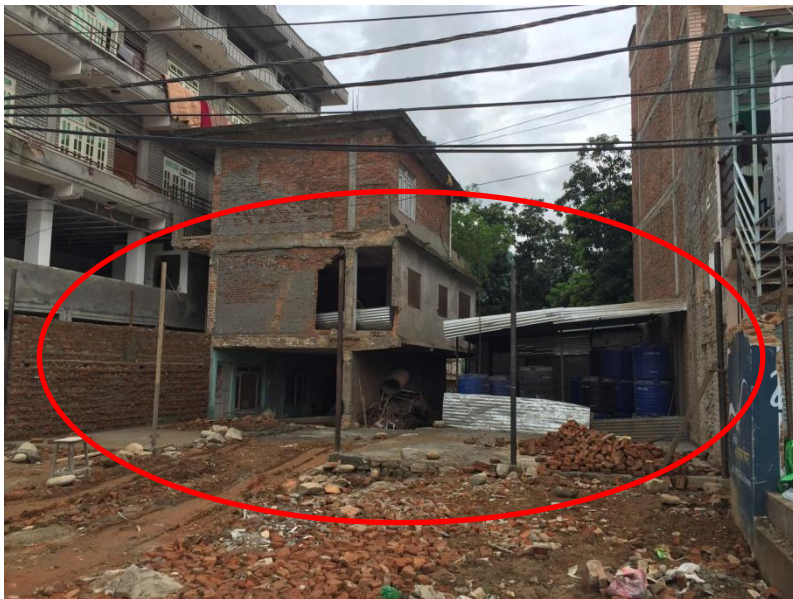
รูปที่ 68 การก่อสร้างบ้านอิฐก่อคล้ายเดิมแต่มีการเพิ่มเสาท่อเหล็กกลมช่วยรับน้ำหนักของหลังคา
