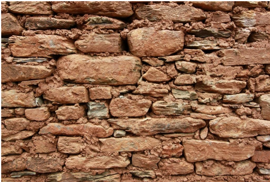
รูปที่ 15 ผิวด้านนอกของกำแพงหินก่อรับแรง ประสานด้วยโคลนทราย(mud mortar)
