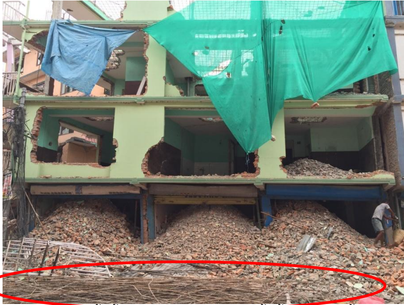
รูปที่ 65 การทุบทำลายอาคารเริ่มจากพื้นชั้นบน และทำการเจาะรูที่พื้นชั้นต่างๆเพื่อทิ้งเศษวัสดุลงมาถึงชั้นล่าง และมีการแยกเหล็กเสริมออกมาขายต่อ
