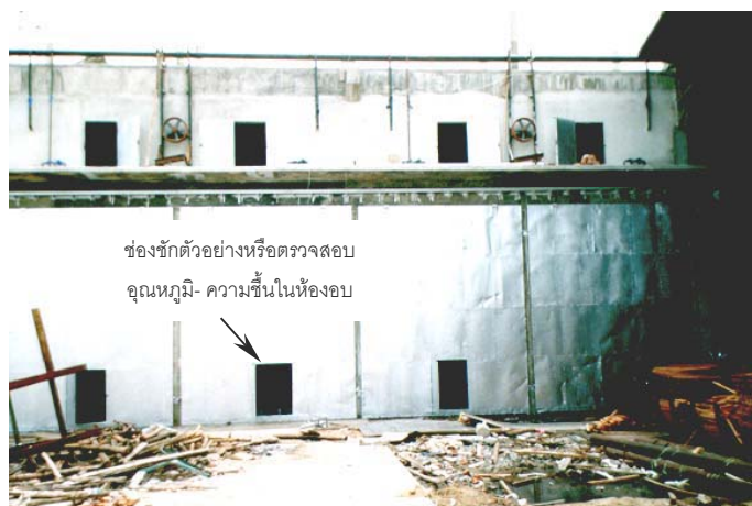
รูปที่ 11 แสดงห้องอบไม้ที่กำลังก่อสร้าง (2)
