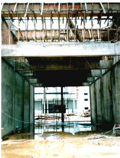
รูปที่ 10 แสดงห้องอบไม้ที่กำลังก่อสร้าง (1)
