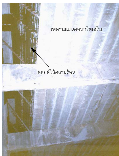
รูปที่ 9 แสดงลักษณะเพดานห้องอบไม้และการวางท่อความร้อนด้านบน
