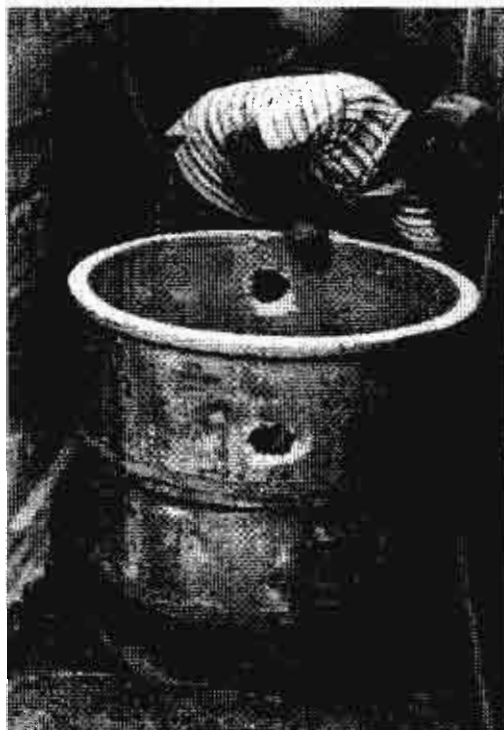
รูปที่ 3-16 ถังเกรอะของชุมชนร่มเกล้า ที่ชาวบ้านร่วมกันสร้างขึ้นเอง
