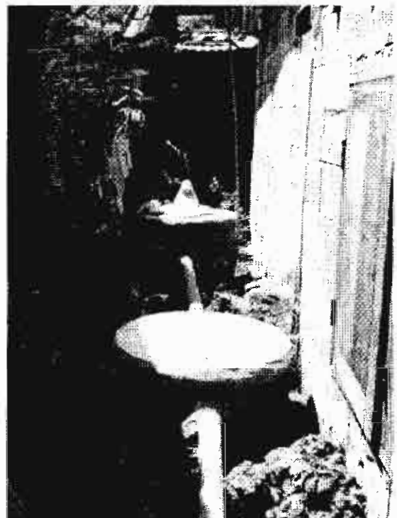
รูปที่ 3-16 ถังเกรอะของชุมชนร่มเกล้า ที่ชาวบ้านร่วมกันสร้างขึ้นเอง
