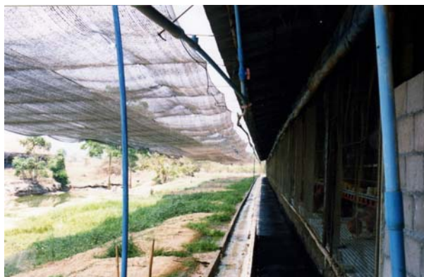
ภาพที่ 6 การใช้ตาข่ายกำบังแดดด้านข้างโรงเรือนเพื่อป้องกันความร้อนจากแสงแดด
