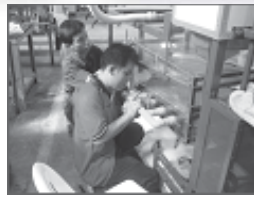
รูปที่ 5 ติดตั้งโบเวอร์ดูด
